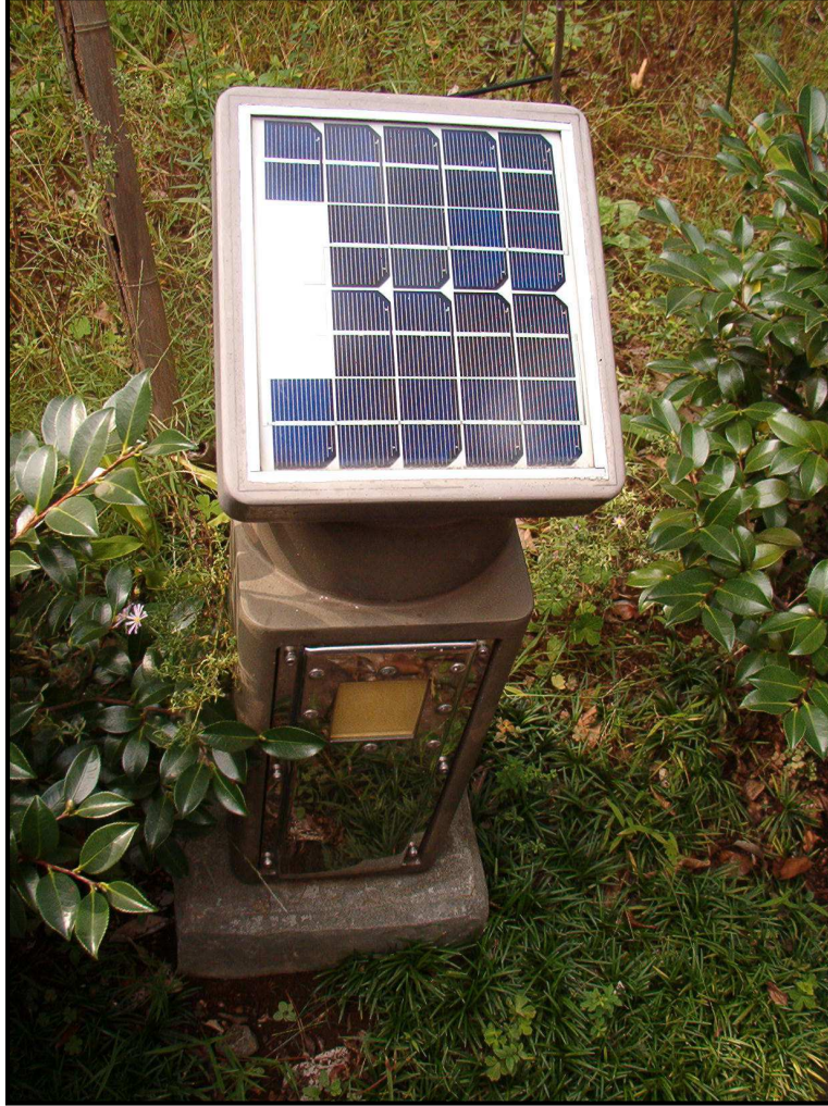
Şekil 5.6 Amasra eko-tek gelişme alanında sokak ve bahçe aydınlatmasında önerilen PV kullanımı (Ercoskun 2007).
