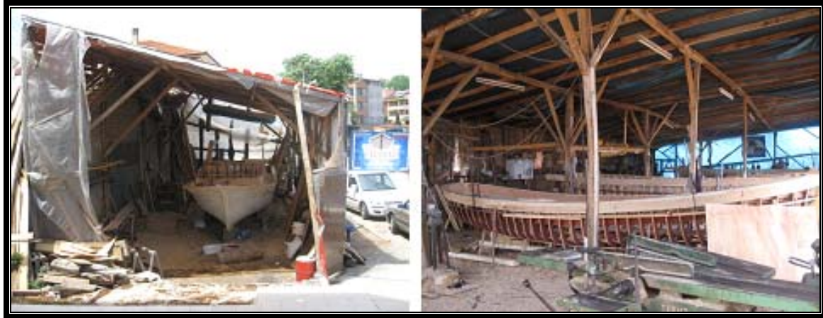
Şekil 4.30 Sahil düzenlemesinin etrafında yer alan tekne yapım atölyeleri.
