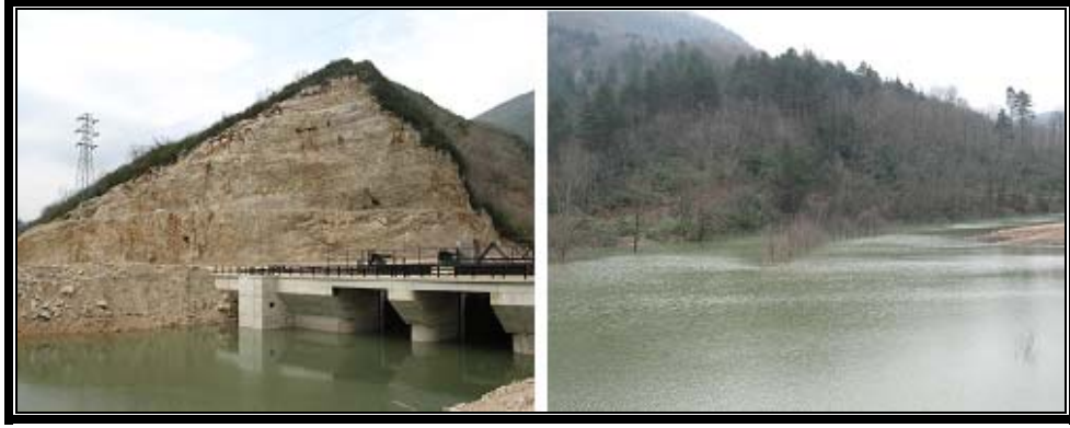
Şekil 4.26 Hidroelektrik santralının çevreye etkileri.
