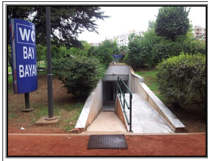
Şekil 4.25 Park içerisindeki tuvaletlerin genel görünümü.
