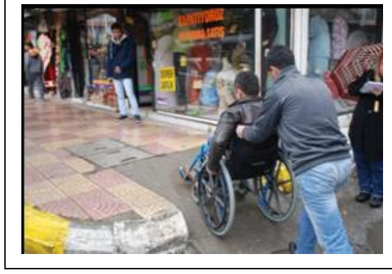
Şekil 2.5 Yaya yollarında düzenlenmiş rampalarda eğimin %6'dan yüksek olması sebebiyle bir başka kişiye ihtiyaç duyan engelli birey (URL-27, 2013).
