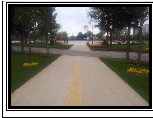
Şekil 2.99 Göztepe 60. Yıl Parkı'nın içinde araç yolu ile yaya yolu arasında kot farkı olmaması örneği (İBB Arşivi 2013).
