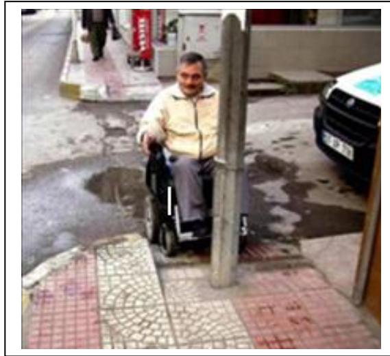
Şekil 2.4 Yapılan yanlış uygulamalar sonucu engelli bireyin ulaşabilirliğinin engellenmesi ( URL-26, 2013 ).
