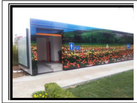
Şekil 2.94 Göztepe 60. Yıl Parkı'nda engellilere uygun park içinde bulunan engelli tuvaleti dış görünümü (İBB Arşivi 2013).
