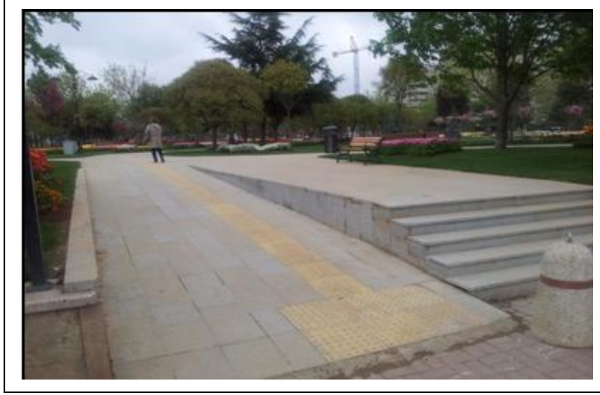
Şekil 2.96 Göztepe 60. Yıl Parkı girişinde engellilere uygun rampa örneği (İBB Arşivi 2013).
