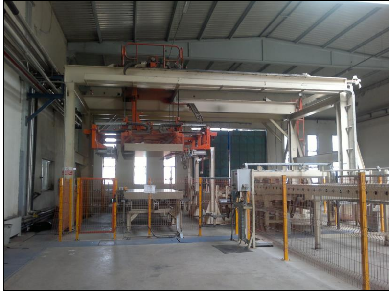
Şekil 18: Pres Sonrası İşlemlerden geçen levhaların boyutlandırılmış görünümü.
