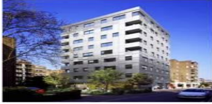
Şekil 8: Ahşap malzemenin yapıda kullanımı (URL-3, 2014).
