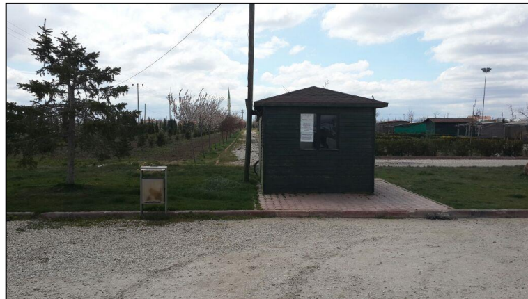
Şekil 22: KKHB güvenlik kulübesi.
