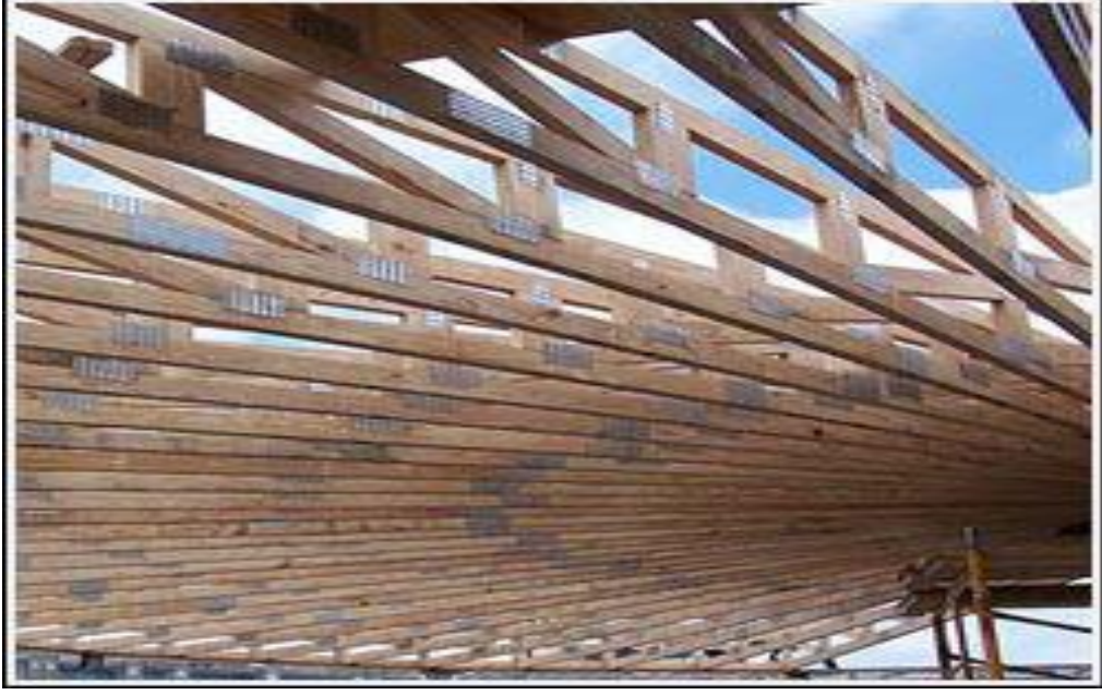
Şekil 4: Ahşap döşeme elemanları (kafes kiriş) (Doğangün vd., 2004).
