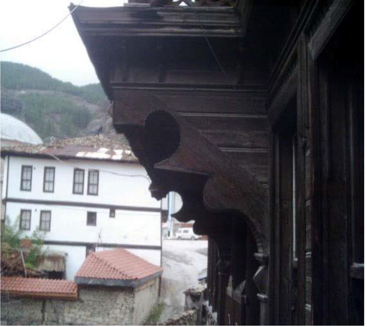
Şekil 17: Ana yapıda yer alan payandanın yandan görünüşü (Öztürk, 2007).
