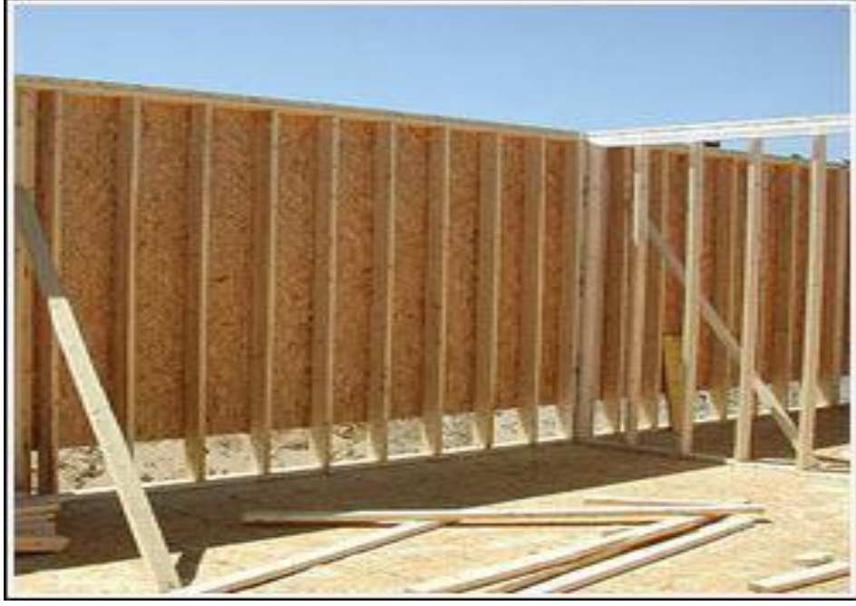
Şekil 5: Ahşap duvar elemanları (Akgül, 2007).
