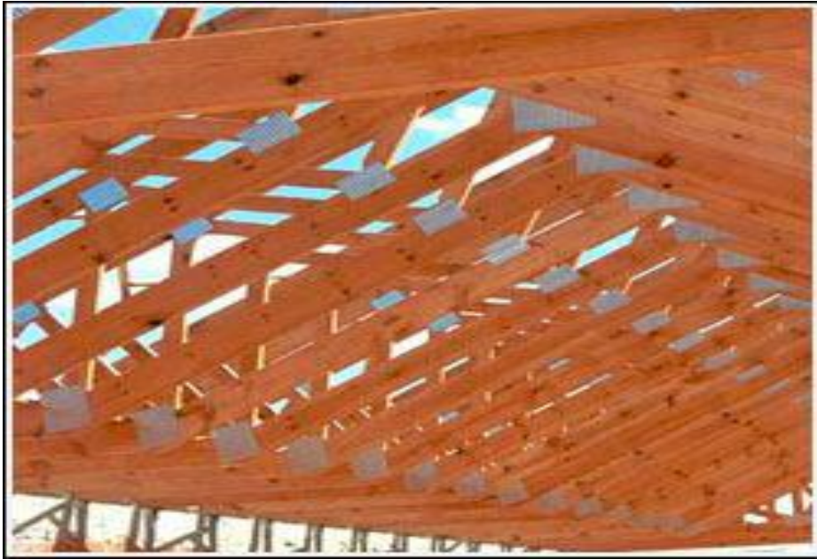
Şekil 6: Ahşap çatı elemanları (Akgül, 2007).
