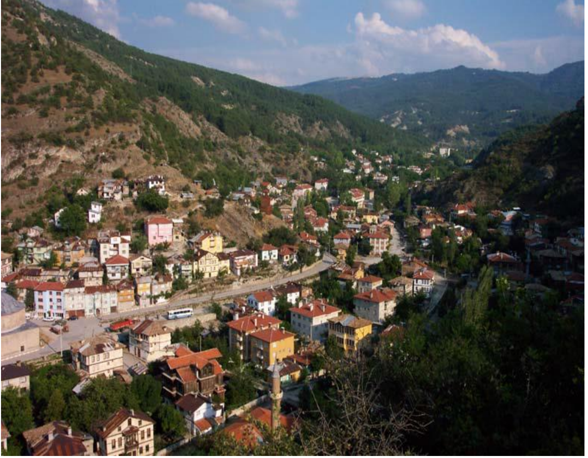
Şekil 9: Mudurnu'nun genel görünümü [Mudurnu Belediyesi arşivi, 2004].
