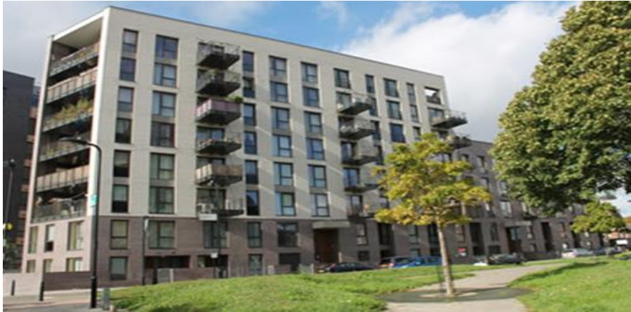
Şekil 13: ÇLK panelle üretilen Bridport konutu (Güzel ve Yesügey, 2015).
