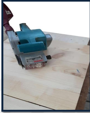
Şekil 28: Tank zımpara ile yüzey düzgünlüğü (Fotoğraf: Z. Eda ÖZAN, 2017).
