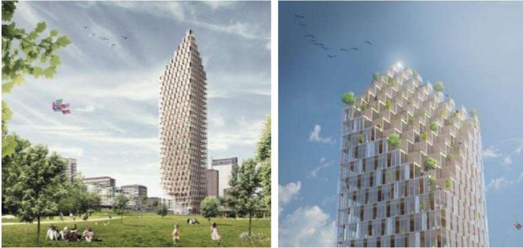
Şekil 15: ÇLK yapı malzemesiyle yapılmış bina örneği (URL-6, 2014).
