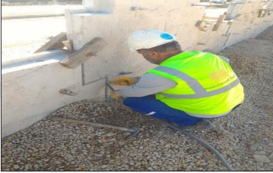
Şekil 17: Polietilen köpük uygulaması.
