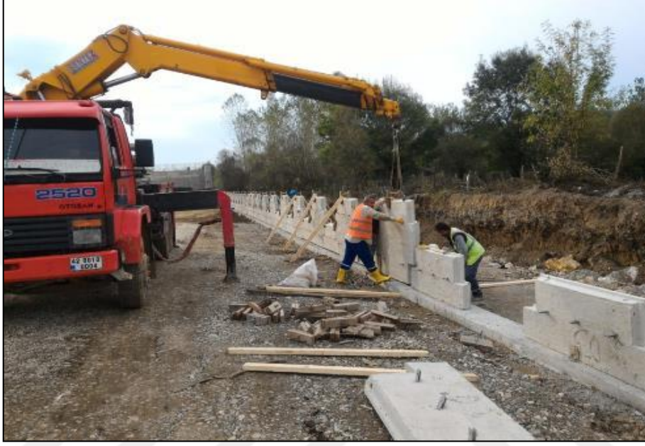
Şekil 20: İlk sıra panellerinin montajı.
