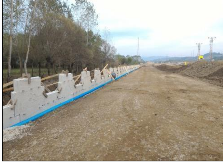
Şekil 24: Drenaj borusu montajı.
