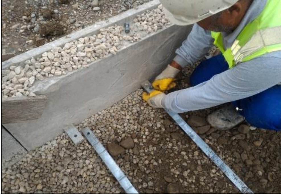
Şekil 16: Pim, cıvata ve somunun uygulanması.
