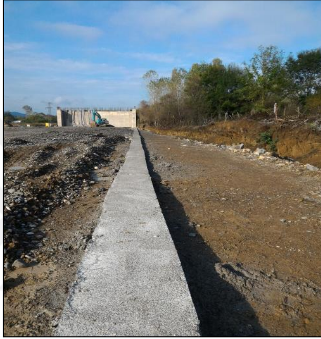
Şekil 19: Tesviye betonunun dökümü.
