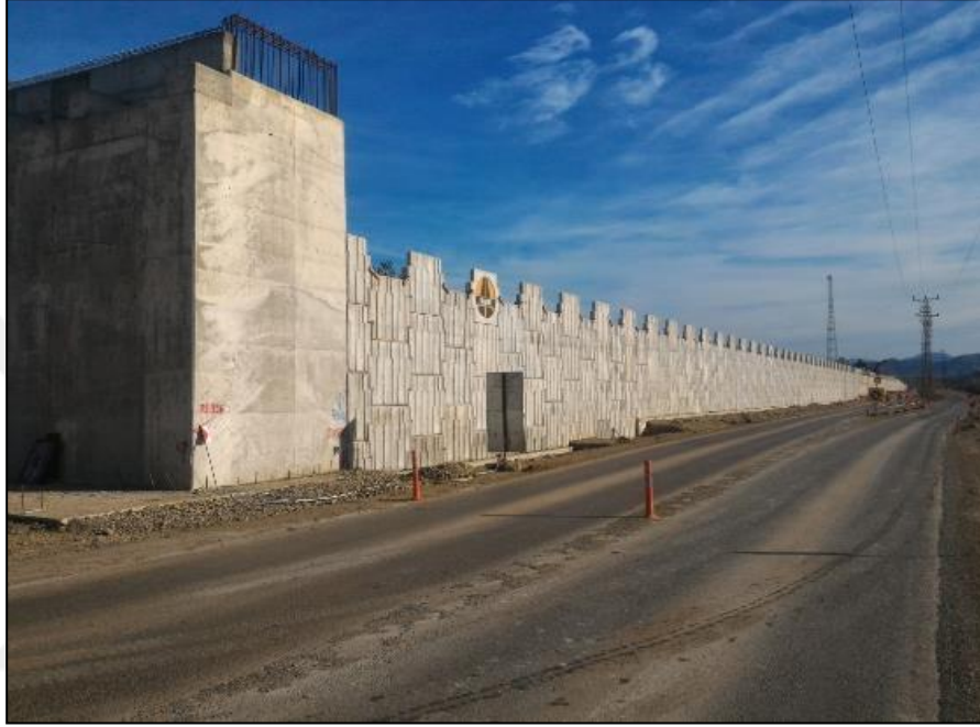
Şekil 10: Şerit donatılı toprakarme duvar yapımı (Kutlubeyyazıcılar – Bartın).
