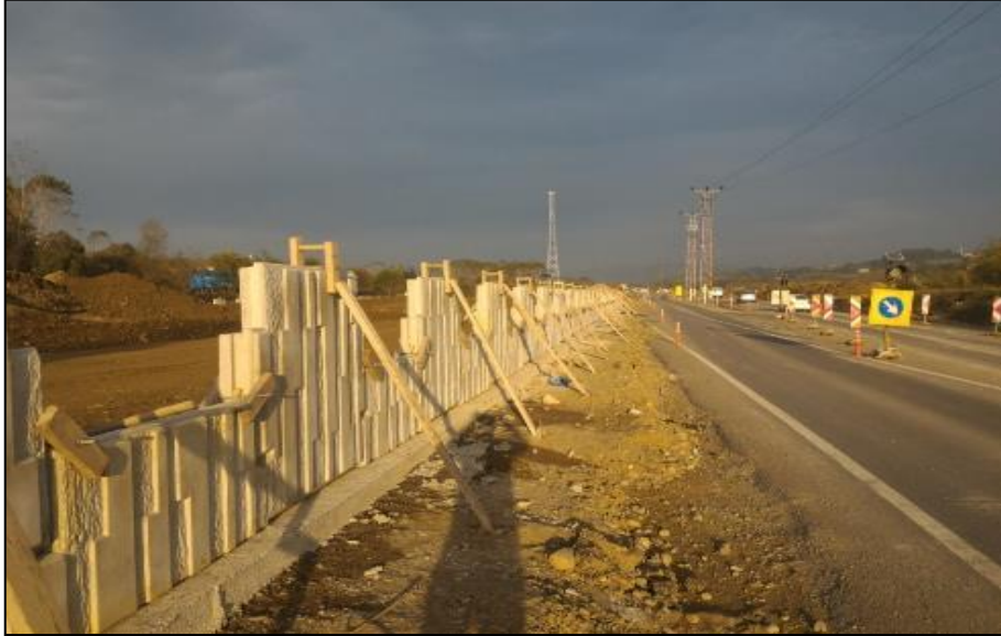
Şekil 21: İlk sıra panellerde payanda kullanılması.
