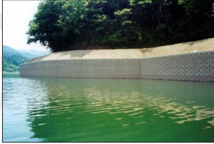
Şekil 6: Su etkisi olan yerlerde yapılan toprakarme (URL-1, 2016).
