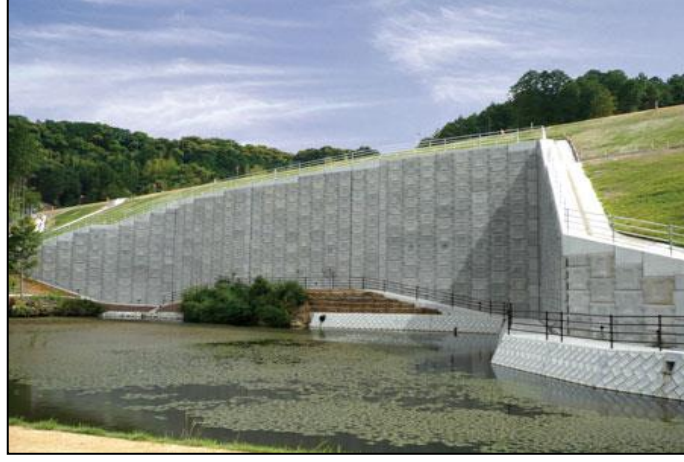
Şekil 5: İstinat duvarı görevinde yapılan toprakarme (URL-1, 2016).
