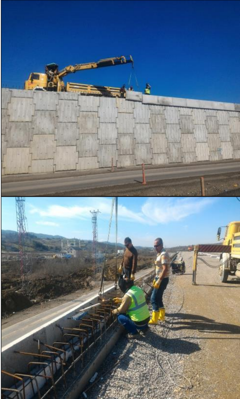
Şekil 26: Harpuşta montajı.
