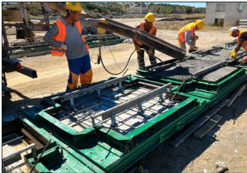
Şekil 12: Prekast panel imalatı.
