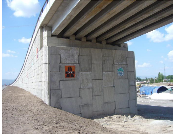
Şekil 7: Köprü kirişlerinin oturacağı mesnet bankı stabilizasyonunda yapılan toprakarme (URL-1, 2016).
