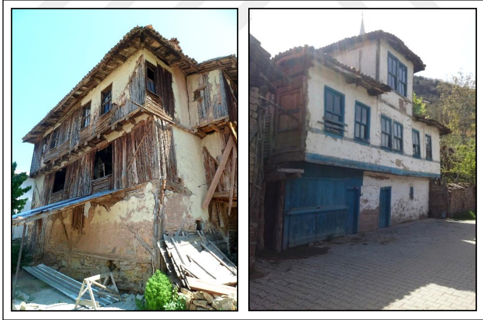
Şekil 4.22: Beydili Mahallesi geleneksel mimarisine örnek.
