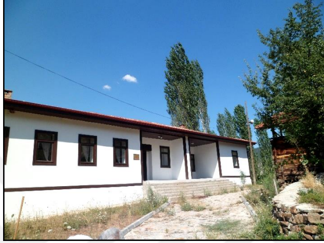
Şekil 4.21: Toplantı salonu olarak restore edilmiş eski okul binası.
