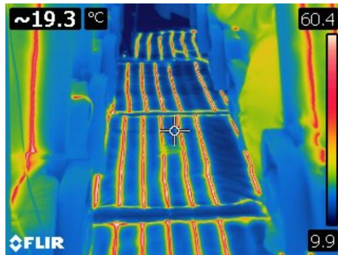
Şekil 4.26: -4 °C dış sıcaklıkta termal kamera zemin görüntüsü.
