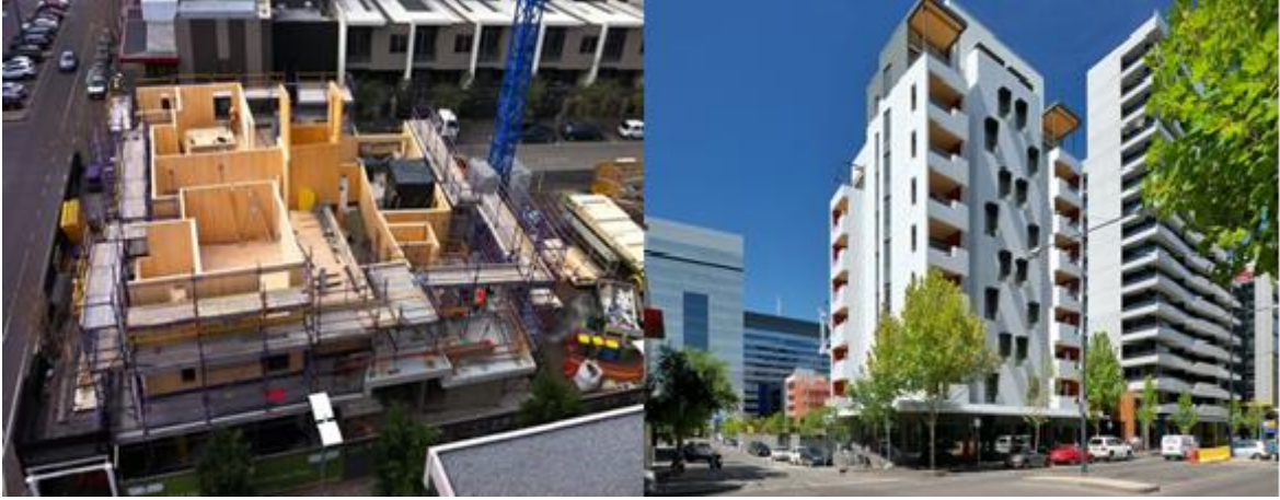
Şekil 1. 18: Forte binası genel görünümü (URL-9, 2012).
