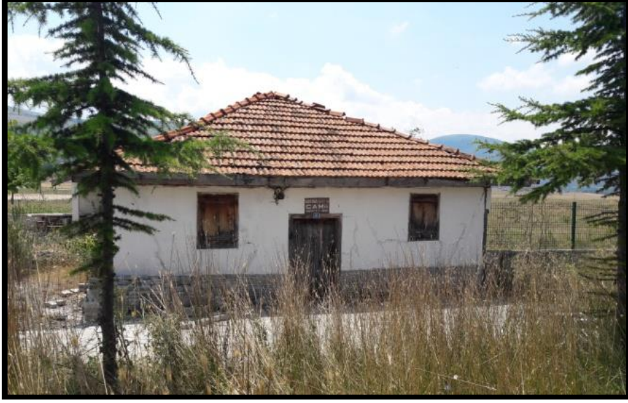
Şekil 5.5: Sığircık Suyu Eski Cami.
