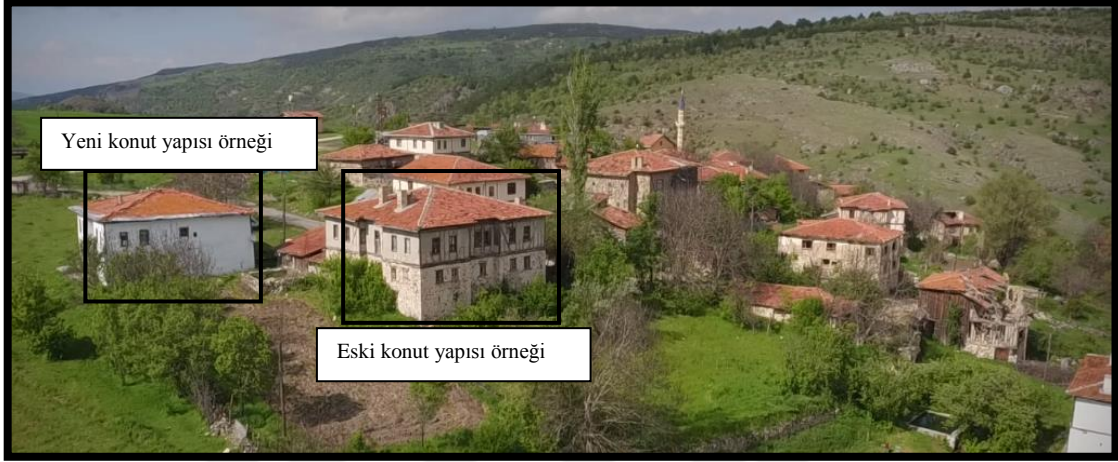
Şekil 3.28: Eskipazar Kırsal Yerleşim Dokusunda eski ve yeni konutlar.
