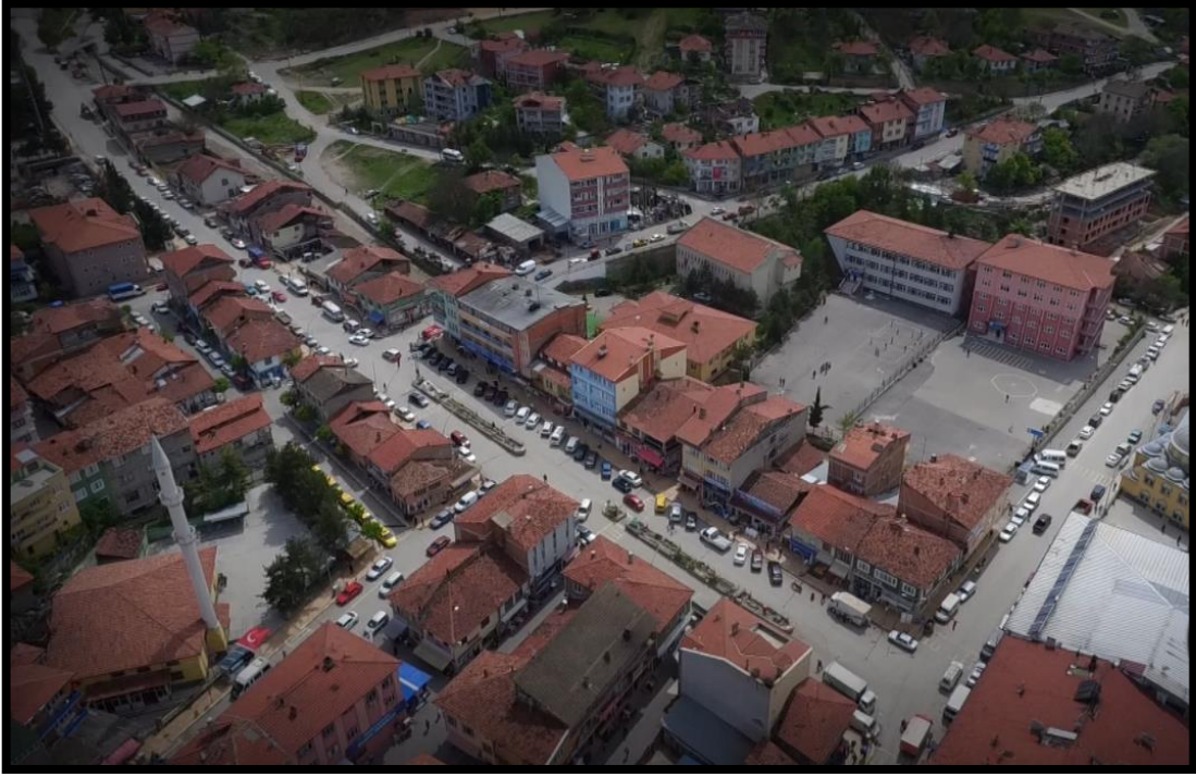
Şekil 3.27: Eskipazar Kent Merkezi'nin havadan görünümü (Eskipazar Belediyesi Arşivi, 2018).
