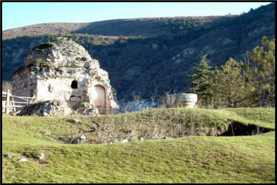
Şekil 3.14: Hamamlı Köyü Osmanlı Hamamı (KVÇŞİM, 2012).
