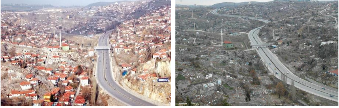
Şekil 4.5: Proje alanı yıkım öncesi ve yıkım sonrası (TOBAŞ, 2007).
