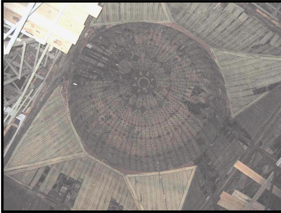
Şekil 6.5: Çelebi Sultan Mehmed Camisi ahşap kubbe konstrüksiyonu
