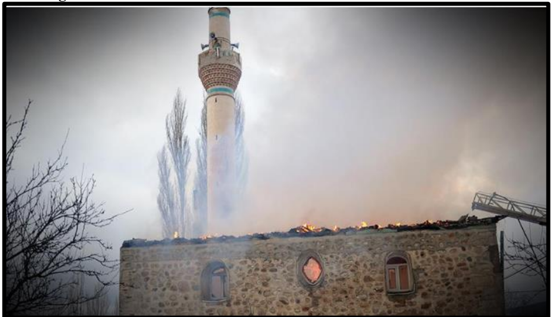
Şekil 6.20: Caminin muhteşem ahşap kubbesinin yangında yok olmasından sonraki görünümü
