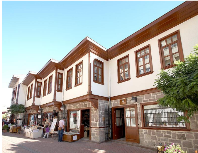
Şekil 5.26. Tarihi Kabakçı Konağı Restorasyon Sonraki Durumu 301
