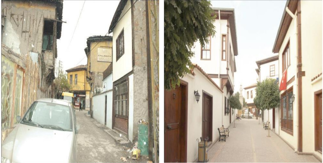
Şekil 5.10. – 5.11. Dutlu Sokak’ın Eski ve Yeni Durumu 277
