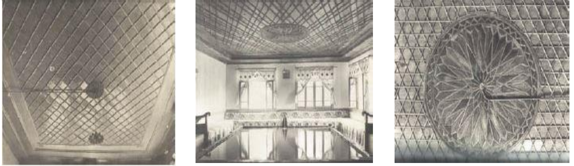
Şekil 6.29. Çıtakâri Tavan Örnekleri 371
