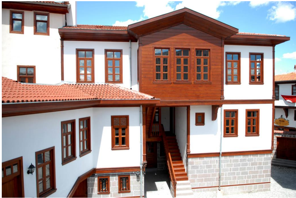
Şekil 6.43. Belediyenin Uygulamış Olduğu Cumba 386
