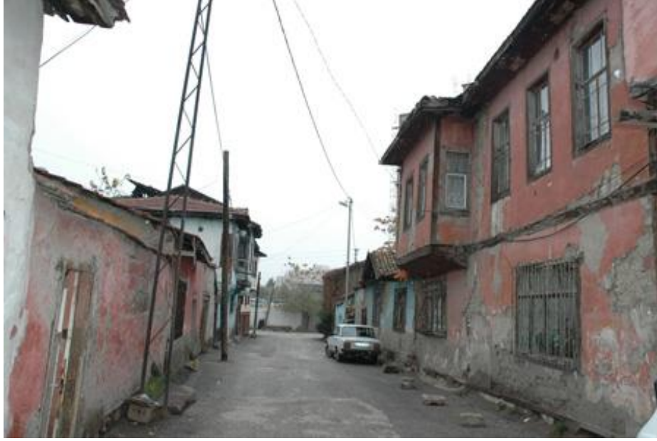
Şekil 5.6. Restorasyon Öncesi Hamamönü Konut Örneği 267
