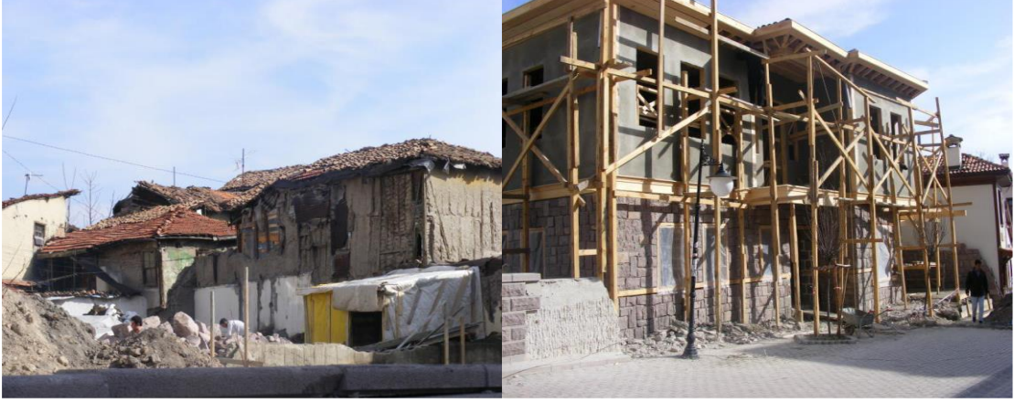
Şekil 6.1. Hamamönü'nde Yıkılan ve Yeni Yapılan Yapılar 338
