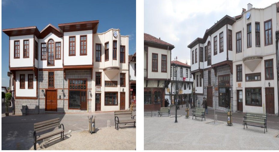
Şekil 6.10. – 6.11. Kamil Paşa Konağı Uygulama Sonucu Oluşan Hali 353
