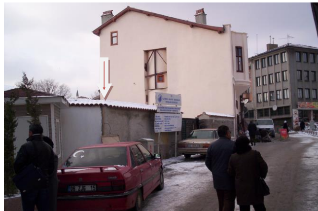
Şekil 5.28. Kamil Paşa Konağı Rekonstrüksiyon Çalışmaları Başlamadan Önceki Durumu 304
