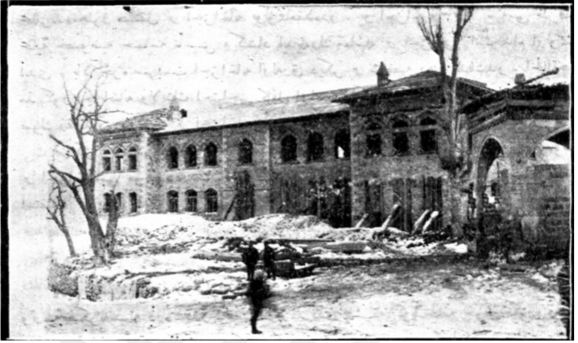
(Vilayet Merkezinde Oluşturulan Köy Yatı Mektebi Binası)
