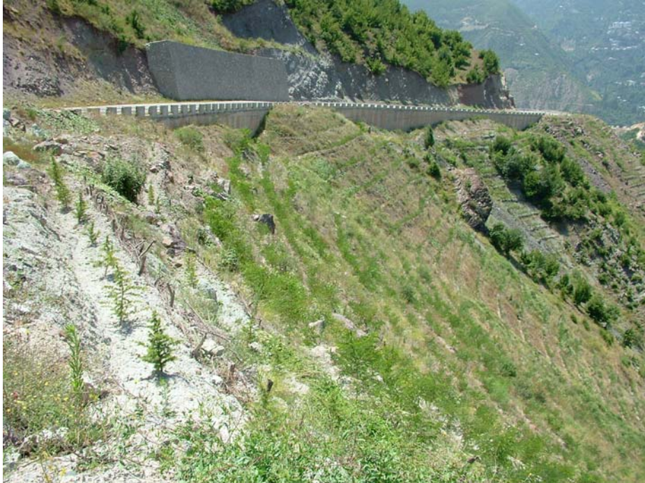
Şekil 13. Çoruh Vadisinde Erozyon Kontrol Amaçlı Yapılan Çalışmalar
