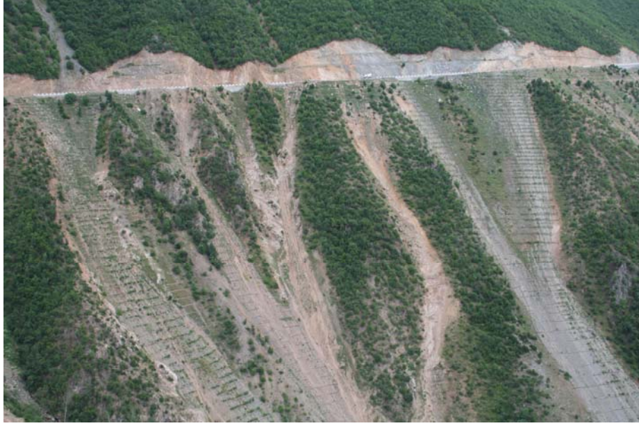
Şekil 2. Baraj Yapım Çalışmaları Nedeniyle Yüksek Kotta Yapılan Yeni Yolların Vermiş Olduğu Tahribat
