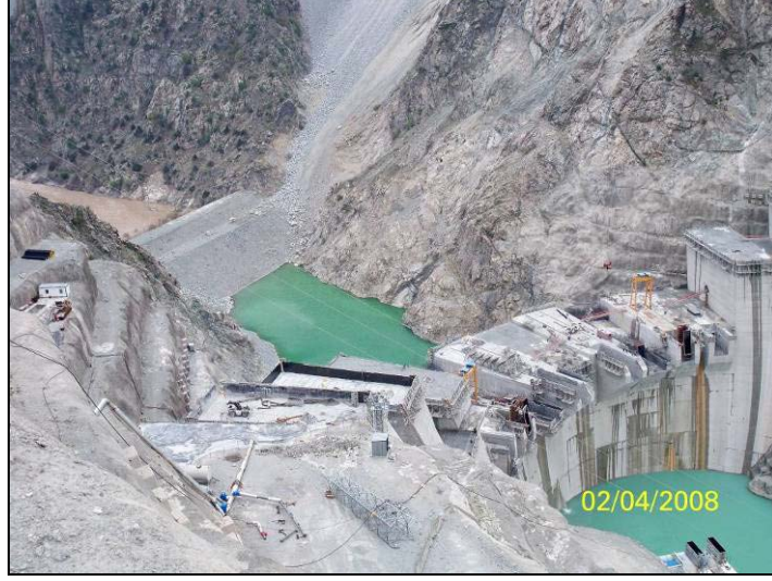
Şekil 8. İnşası devam eden Deriner Barajından bir görünüm.
