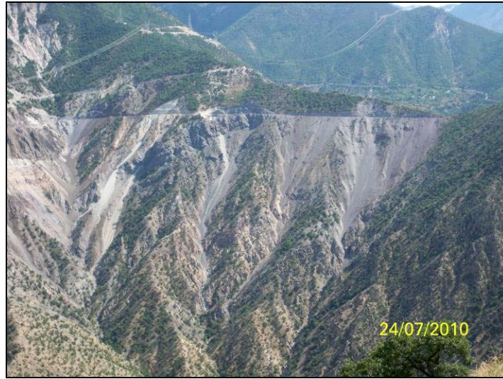
Şekil 3. Yol yapımı sırasında oluşan kazı malzemesinin şevlerden aşağı gelişigüzel bir şekilde atılması ile oluşan arazi tahribatı sonucu zarar gören bitki örtüsünden bir görüntü.
