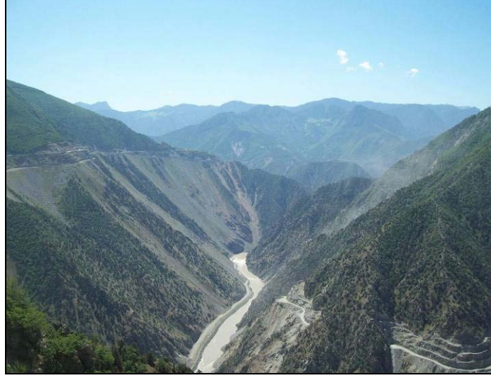
Şekil 2. Yol yapımı sırasında oluşan kazı malzemesinin şevlerden aşağı gelişigüzel bir şekilde atılması ile oluşan arazi tahribatı sonucu su kaynağında oluşan zararın görüntüsü.
