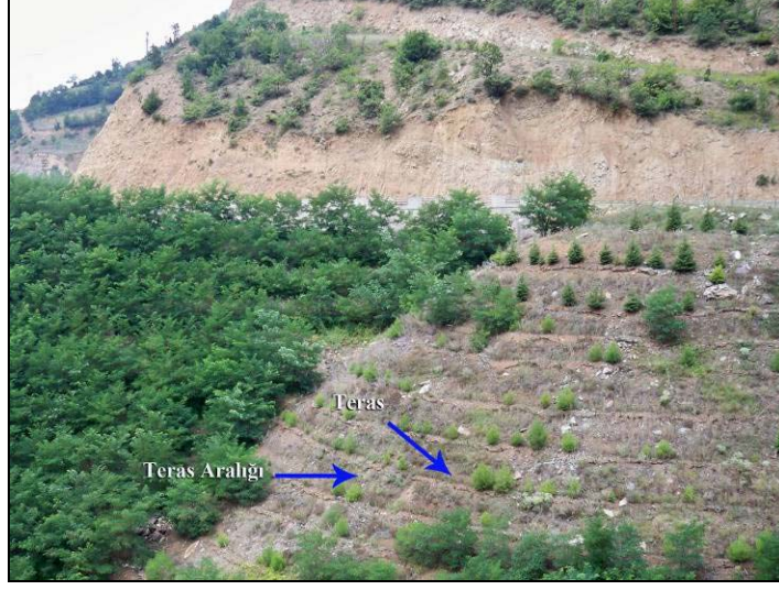
Şekil 18. Erozyon kontrolü ve ağaçlandırma çalışmalarının yapıldığı alandaki teras ve teras aralığının görüntüsü.
