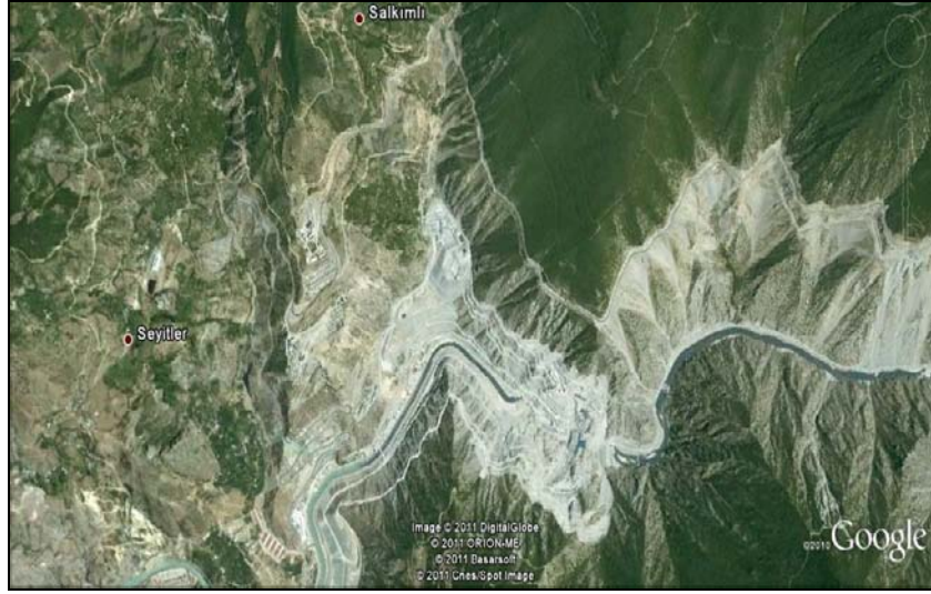
Şekil 12. Çoruh Nehrinde baraj çalışmaları nedeniyle yüksek kotlara çıkarılan karayolu ulaşım ağının inşasının neden olduğu arazi tahribatı ve toprak erozyonunun uydu görüntüsü.
