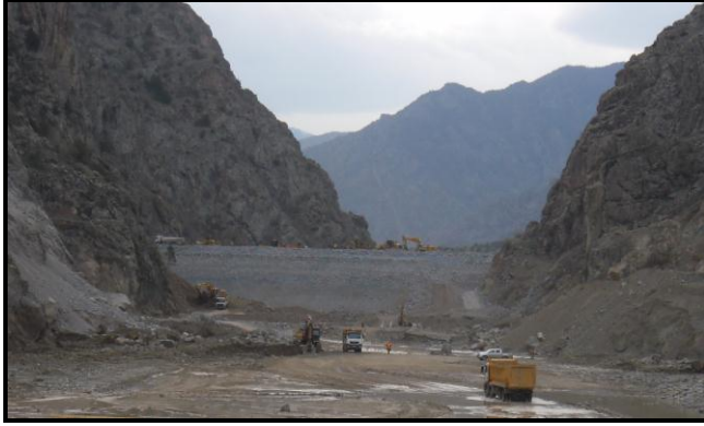
Şekil 9. Arkun Barajı gövde inşaatına ait bir görünüm
