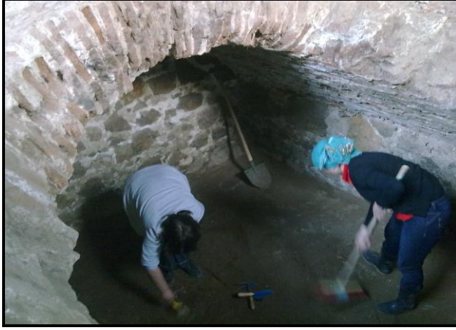
Şekil 17. Aşağı Türbe Bakım Çalışmaları
