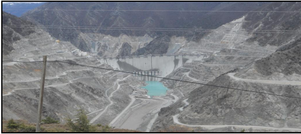
Şekil 8. Deriner Barajına ait bir görünüm
