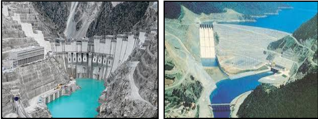
Şekil 1.a) Deriner Barajı gövdesi b) Dolusavak örneği
