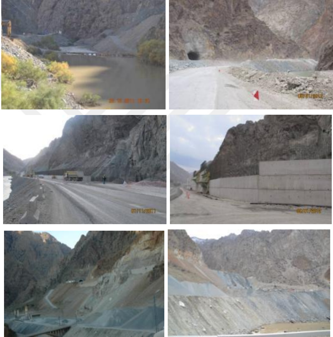
Şekil 95. Çoruh Vadisi YHGS - İnşaat Çalışmalarının Habitatlara Etkisi
