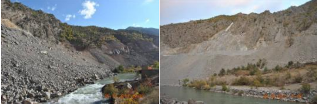
Şekil 90. Verçenik Dağı YHGS - Yol İnşaatlarından Genel Görünümler
