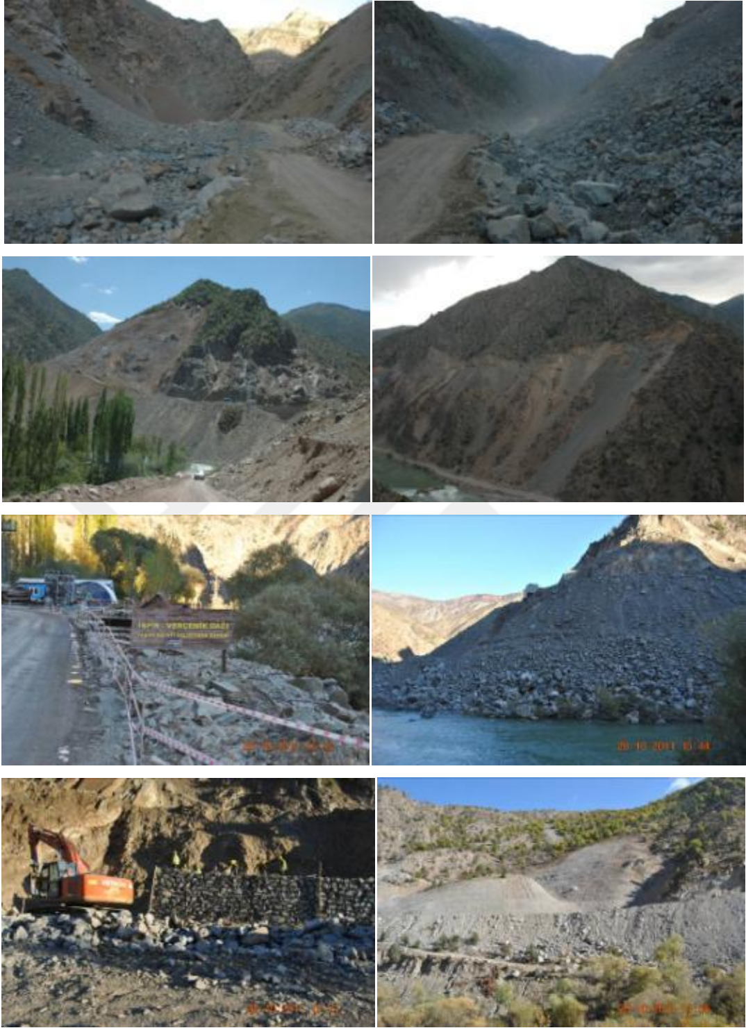
Şekil 89. Verçenik Dağı YHGS - Yol İnşaatlarından Genel Görünümler
