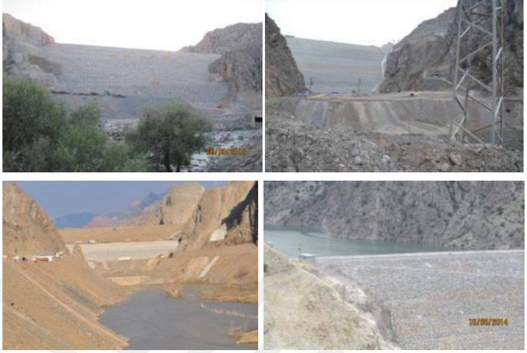
Şekil 87. Arkun Barajı İnşaatından Genel Görünümler
