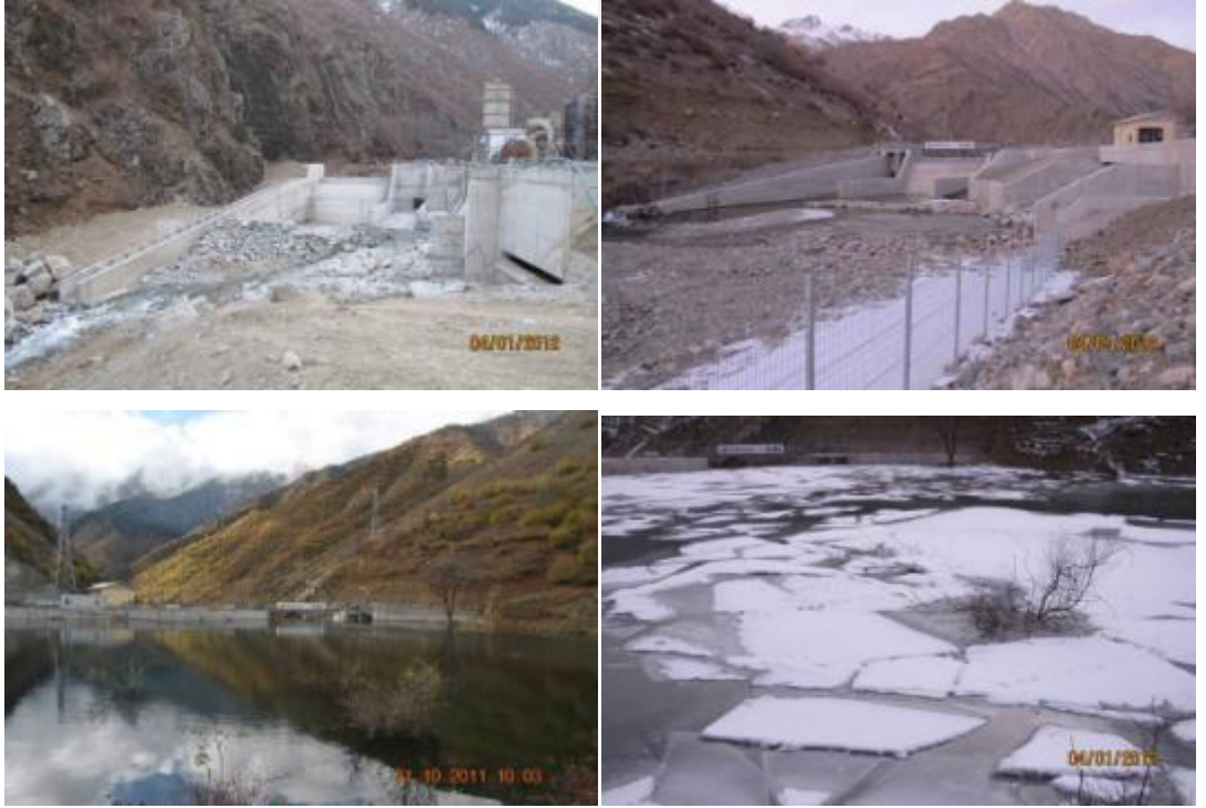
Şekil 92. Aksu HES ve Balık Merdivenlerinden Görünümler
