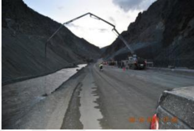
Şekil 26. Çoruh Vadisi YHGS - Artan Beton Harcın Nehre Boşaltılması
