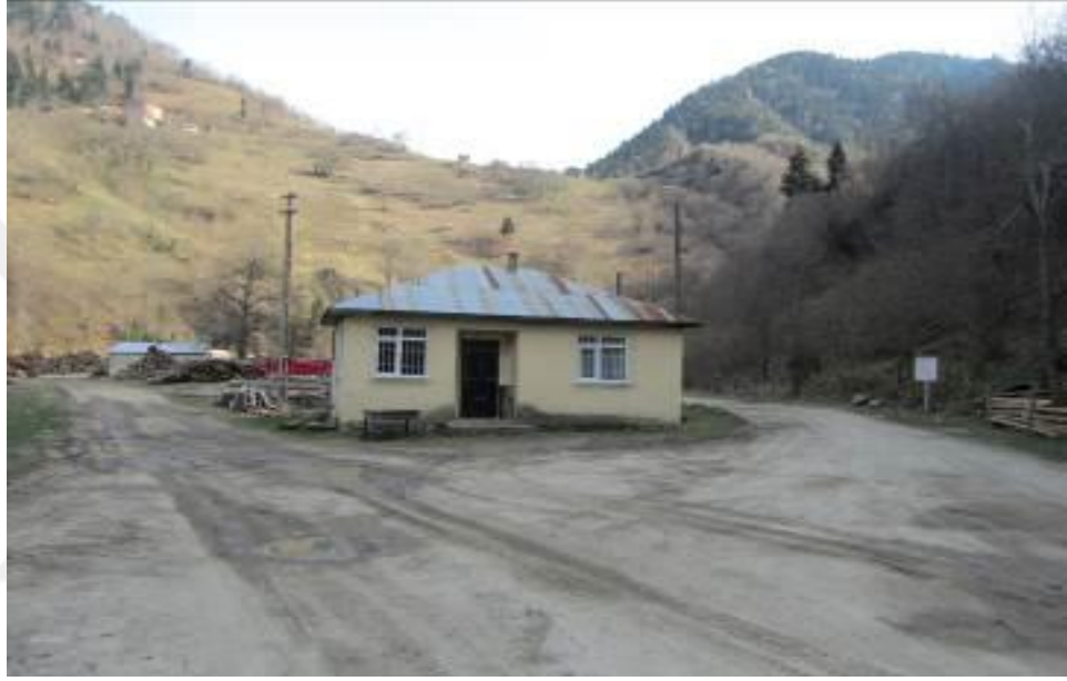
Şekil 13 Depo girişinin kontrolsüzlüğü
