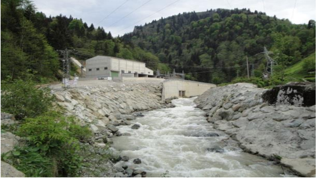
Şekil 12 Dere ıslahı örneği
