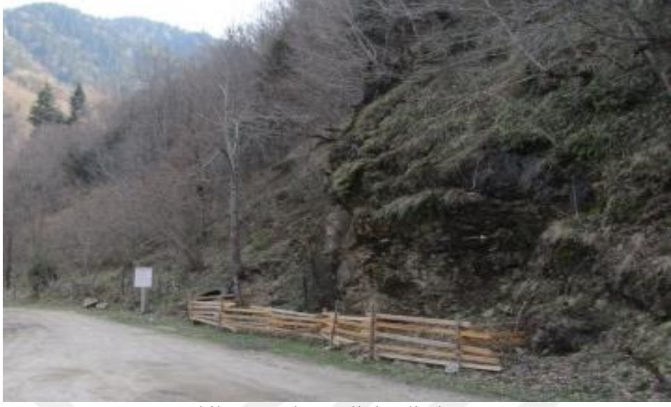
Şekil 8. Taş düşme ihtimali olan şev
