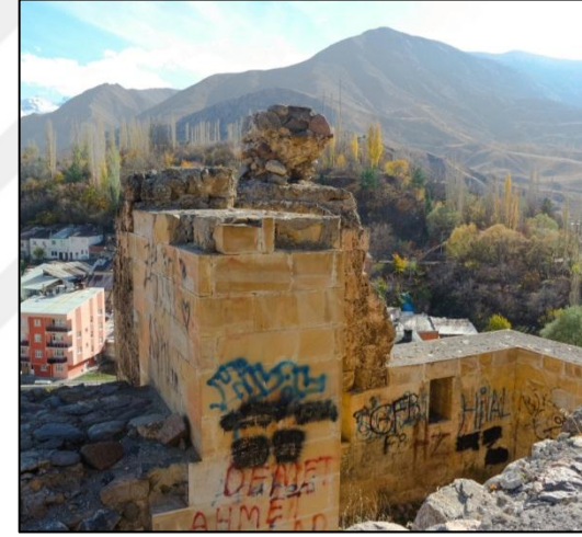
Şekil 50. Kale içine yapılmış beton yapılar ve yanlış restorasyon uygulamaları
