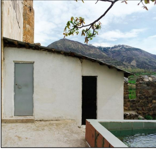
Şekil 50. Kale içine yapılmış beton yapılar ve yanlış restorasyon uygulamaları
