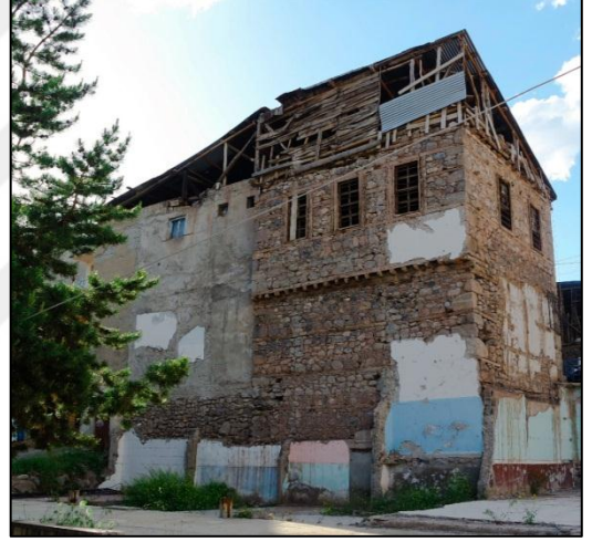
Şekil 41. Geleneksel-beton karma yapı örneği
