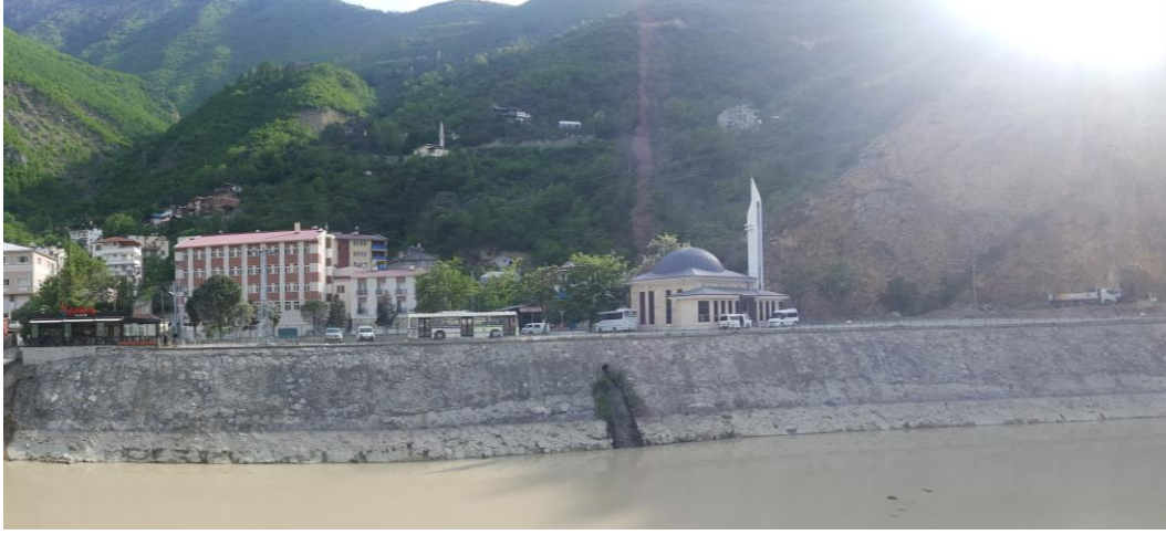
Şekil 70. Yeni yapılan camii ve çevresinin görünümü
