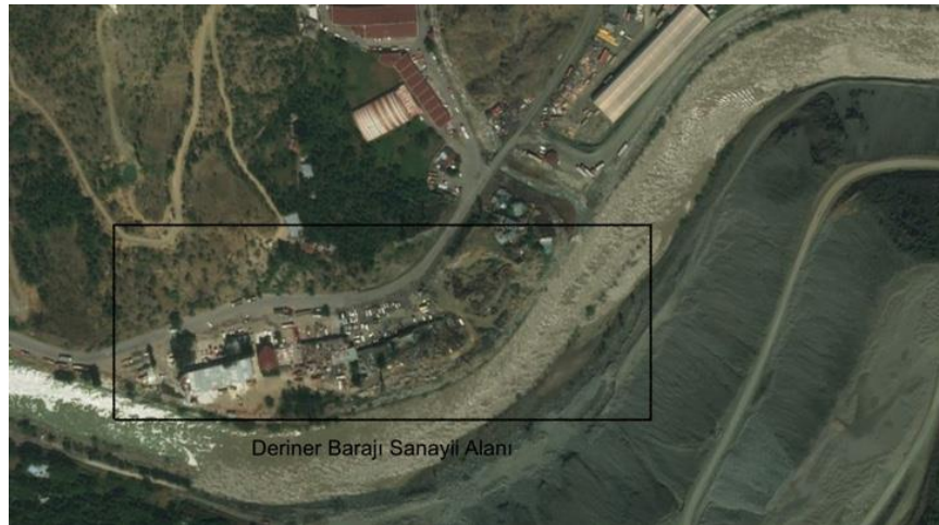
Şekil 65. Deriner barajı sanayi alanı uydu görüntüsü
