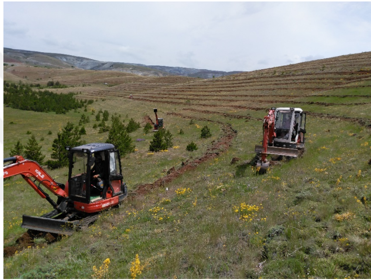
Şekil 2. Mini ekskavatörle toprak işleme
