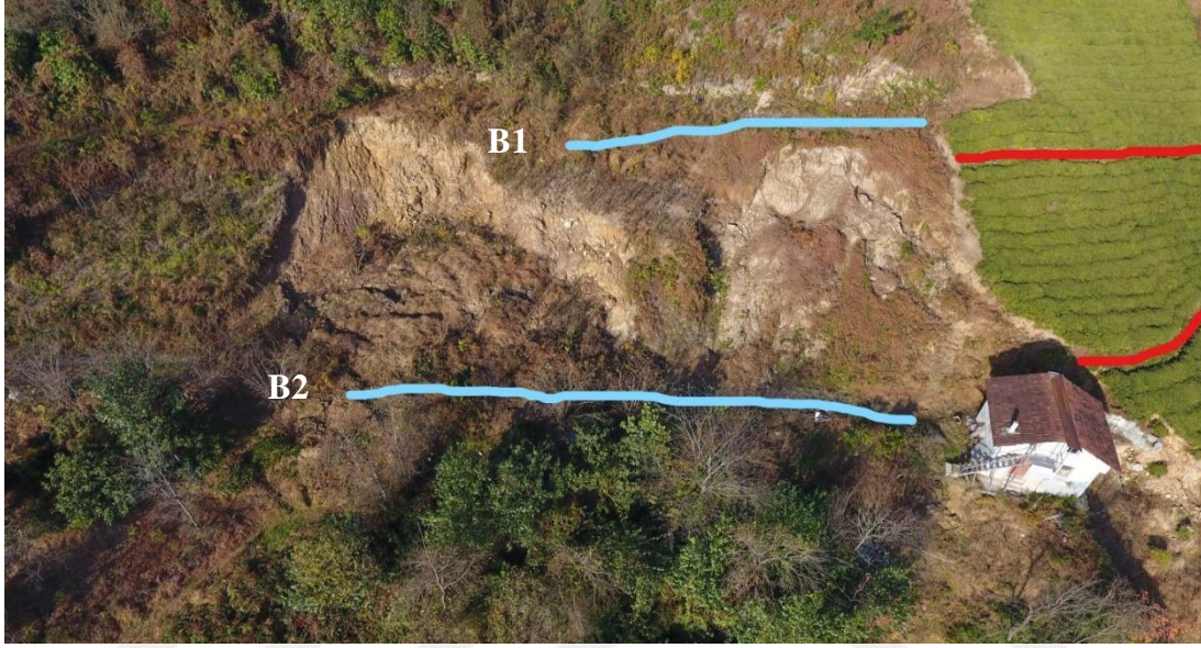
Şekil 103. Yol ve Cılız bitki örtüsü olan bölge (Heyelan Sonrası)
