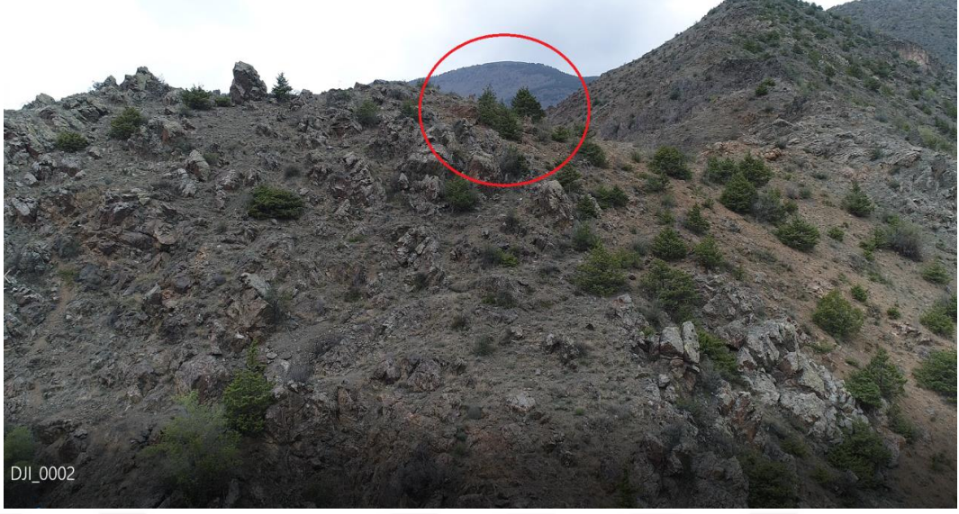
Şekil 23. 16 Nolu Gözleğe Ait Dron Görüntüleri – 29.04.2019
