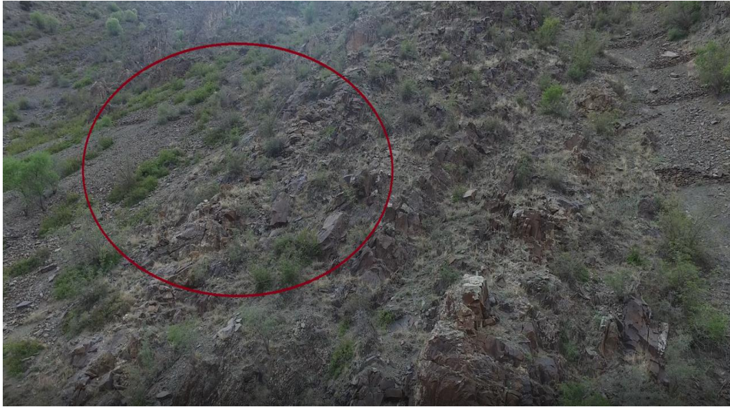
Şekil 22. 18 Nolu Gözleğe Ait Dron Görüntüleri – 29.04.2019
