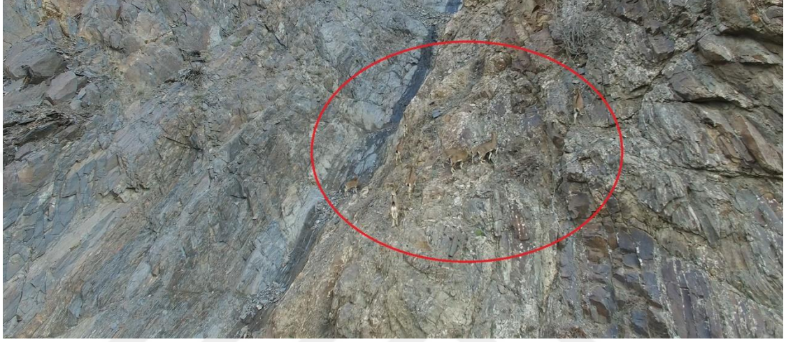
Şekil 21. 18 Nolu Gözleğe Ait Dron Görüntüleri -15.12.2018
