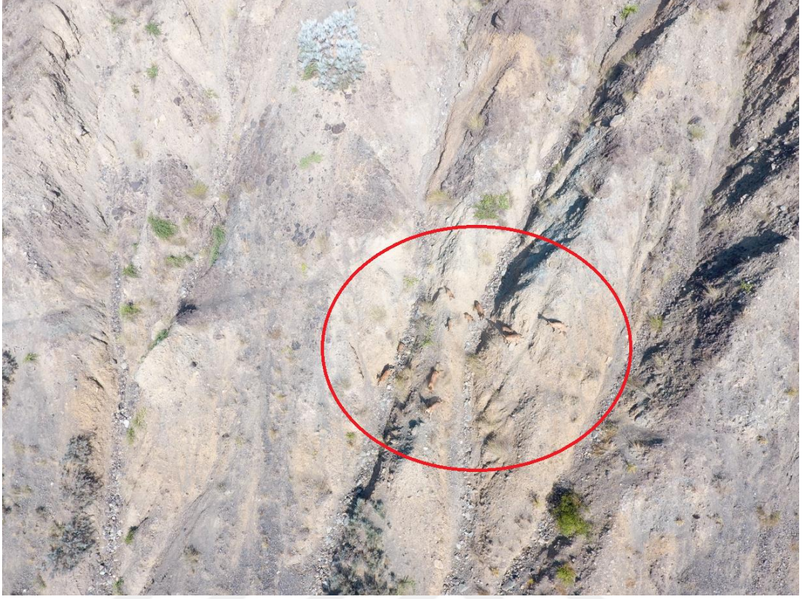
Şekil 26. 18 Nolu Gözleğe Ait Dron Görüntüleri – 18.07.2019
