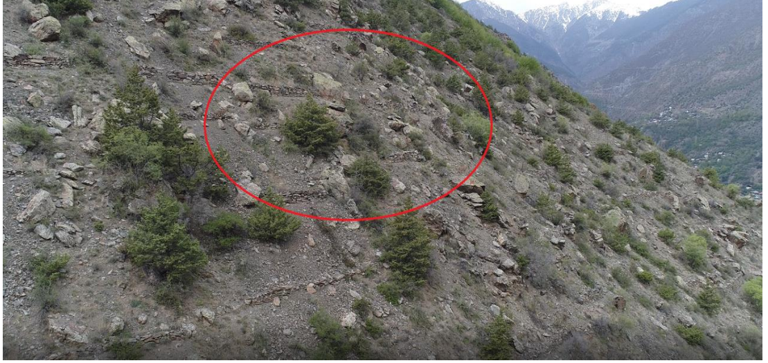
Şekil 24. 16 Nolu Gözleğe Ait Dron Görüntüleri – 29.04.2019
