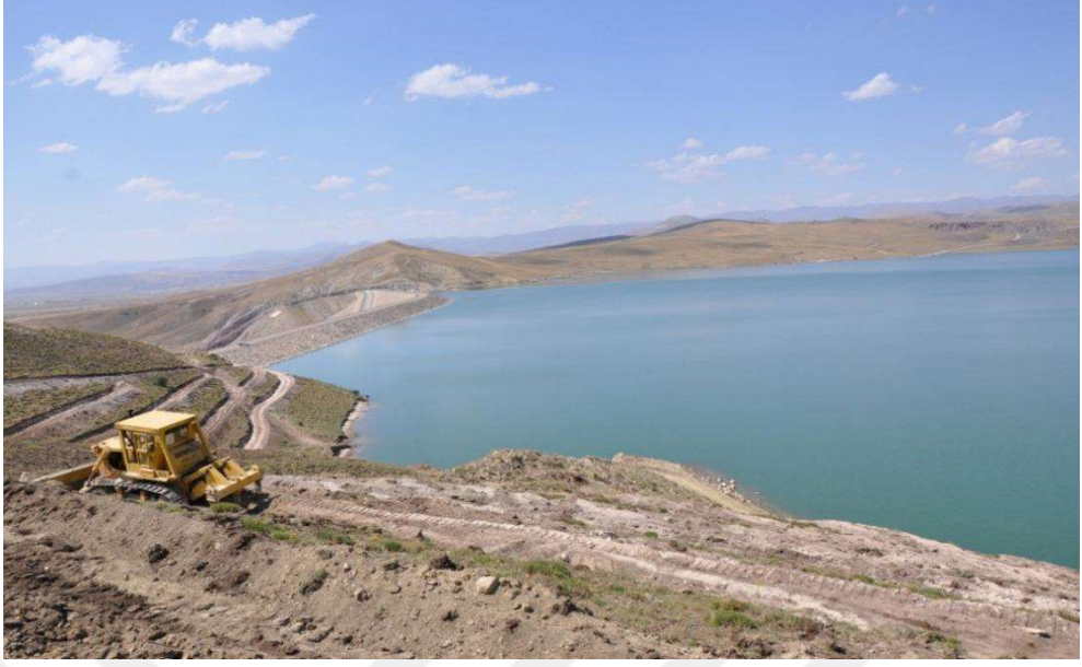
Şekil 15. Makinalı çalışma ile seki teras yapımı
