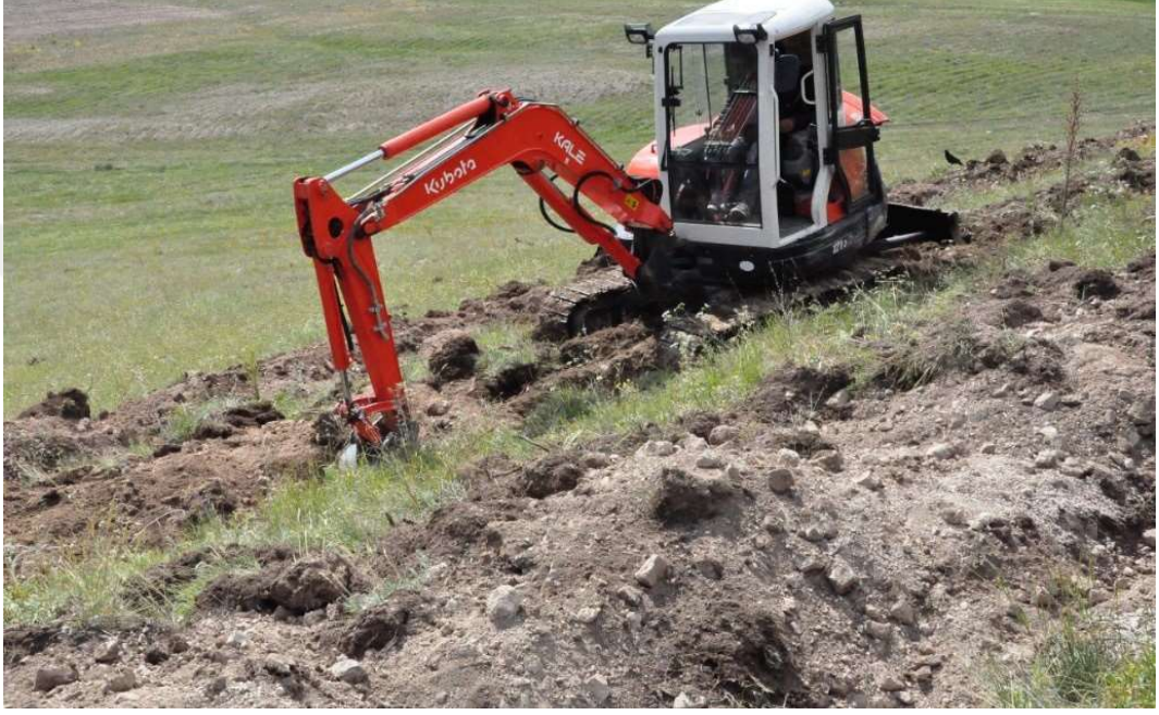
Şekil 14. Ekskavatörle gradoni şeklinde teras yapımı
