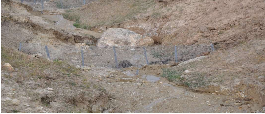
Şekil 12. Galvanizli kafes tel eşik yapımı
