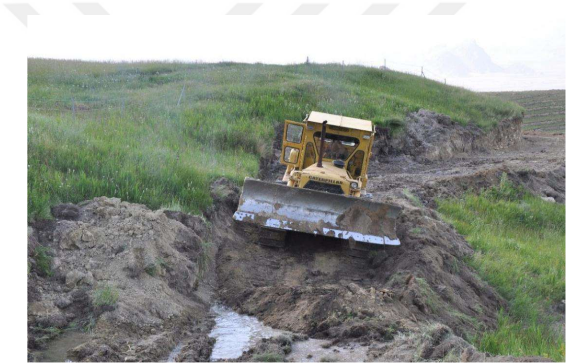
Şekil 10. Servis yolu yapımı
