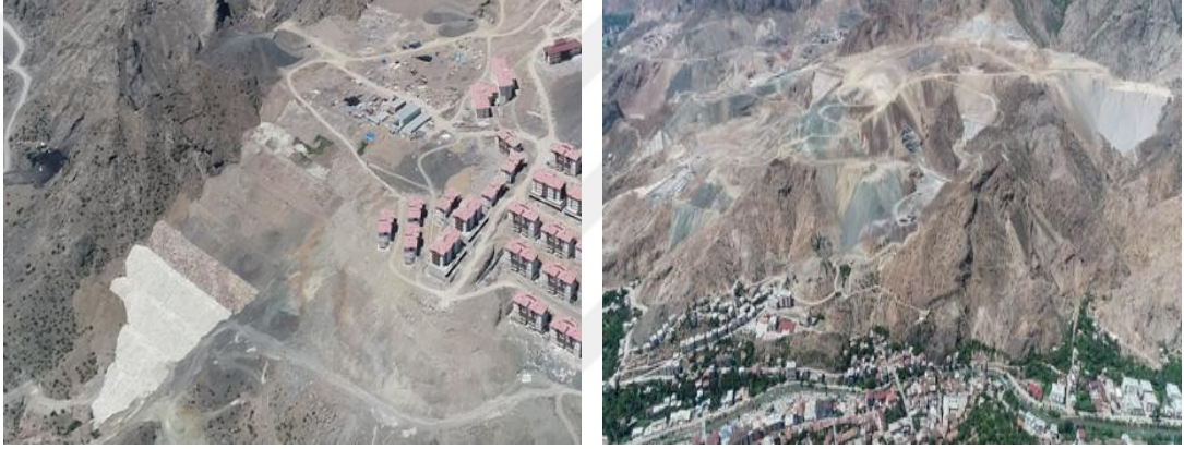
Şekil 45. Yeni yerleşim alanında yapılan istinat duvarlarından ve yapılan kazı dolgu çalışmalarından örnekler
