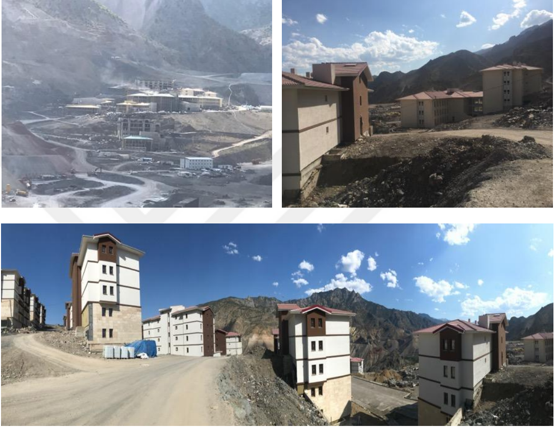
Şekil 52. Yusufeli İlçesi yeni yerleşim yerindeki konut görüntüleri
