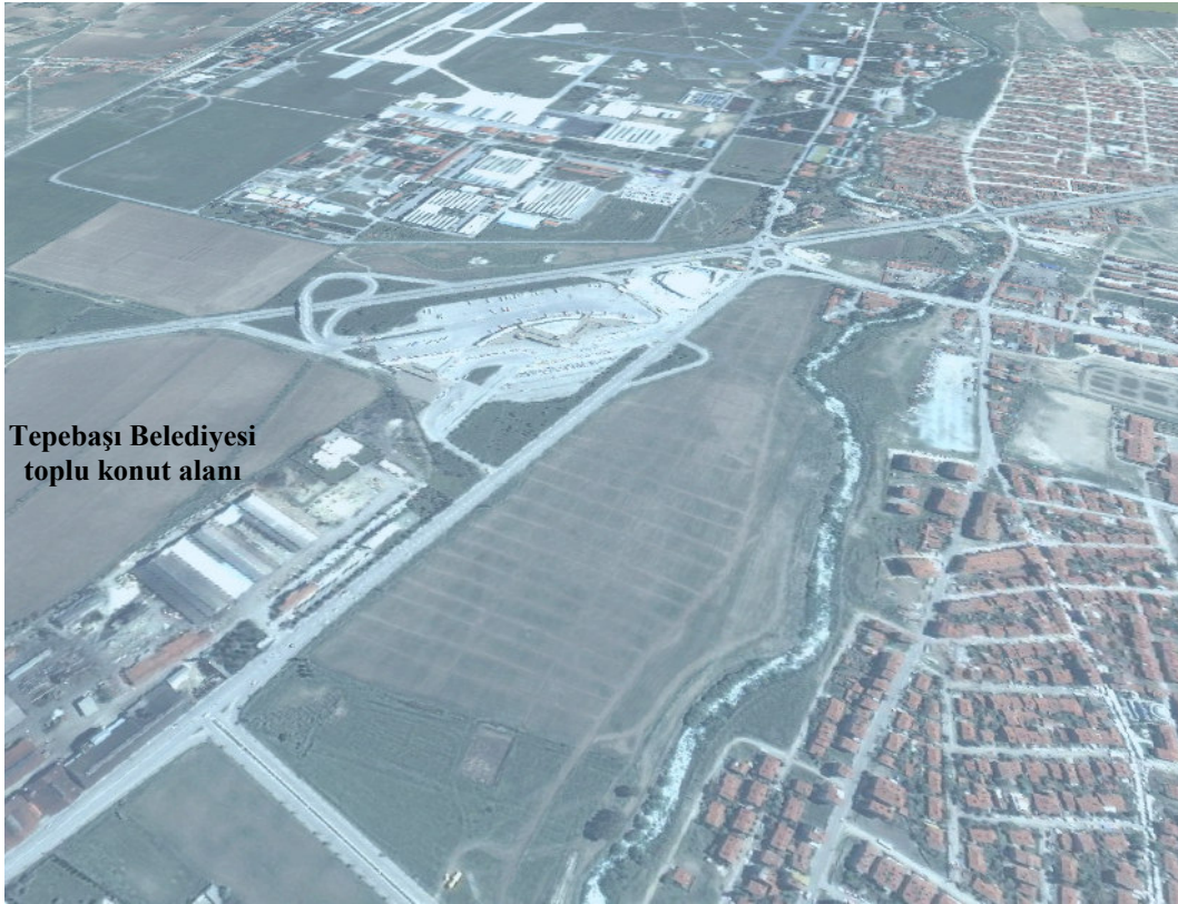
Şekil 4.105. Tepebaşı Belediyesi toplu konut alanlarının güneybatı yönünden görünüşü
