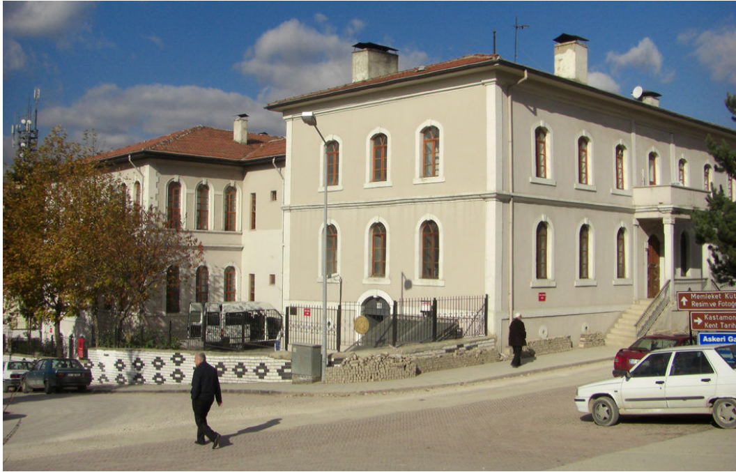
Resim – 4.7 Valilik binasının kuzeyinden Askeri Depo ve Askerlik Dairesi binalarına bakış (2009) (Fotoğraf: D. Sezer).
