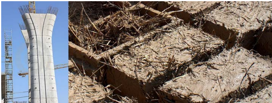
Görsel 1.1. Yapısal kompozit örnekleri olarak modern betonarme sütun ve kerpiç
