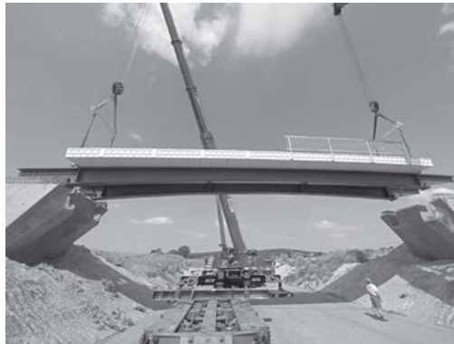
Görsel 2.5. CTP köprünün Frankfurt yakınlarındaki B3 otoyoluna yerleştirilmesi [16]
