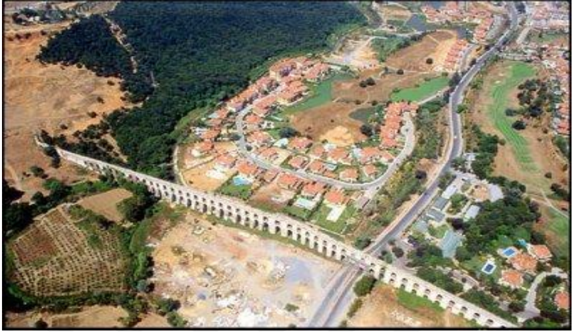
Şekil 4.6. Kemer Country- İlk faz olan Kemerboyu yerleşiminin inşası (Oğuz Meriç)
