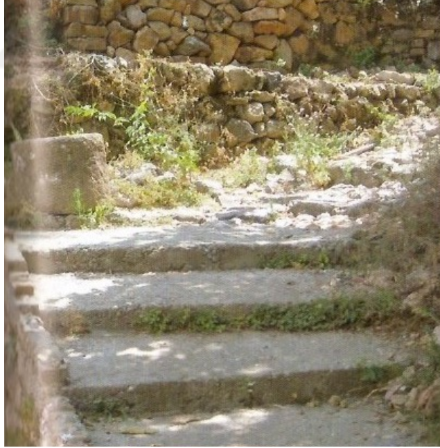
Görsel 3.45. Alanya Tophane Mahallesi'nde bir umumi merdivenin sahanlığındaki dinlenme taşı. (Seydioğulları, tarihsiz)
