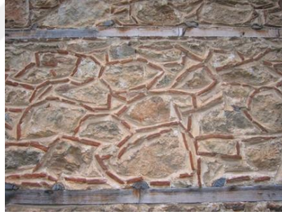
Resim 4.33b. Taş duvarda kiremit kırıkları ile geleneksel "çivileme" derz tekniği
