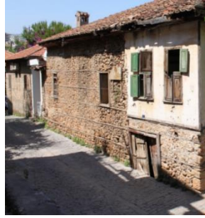
Resim 4.27. Güney cephesi yeşil panjurlar
