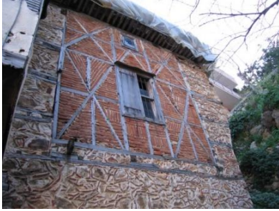
Resim 4.33a. Kuzey cephesi, yatak odasının dış duvarından detay
