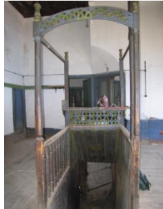
Resim 4.33d. Üst kat ahşap merdivenin çıkış bölümü
