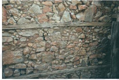
Resim 4.16. Kırılma yüzeyi gri-mavi renkli kalker, Küçük dolgu taşlar
