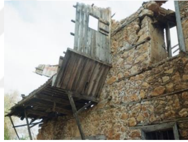
Resim 4.42c. Ahşap çıkma
