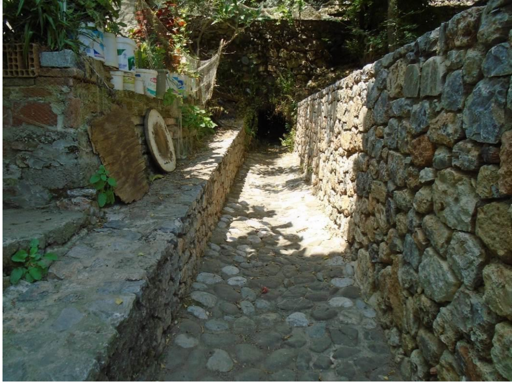
Görsel 3.36. Tophane Mahallesi Meyyit Kapısı Drenaj Kanalı (Akman, N.)
