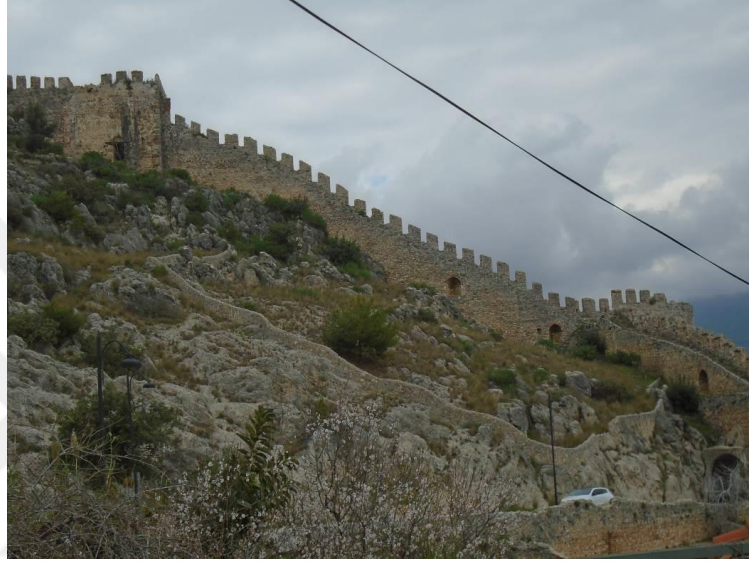
Görsel 3.49. Alanya Kalesi 282 ada 3 parsel Temiz Su Havzası (Akman, N.)
