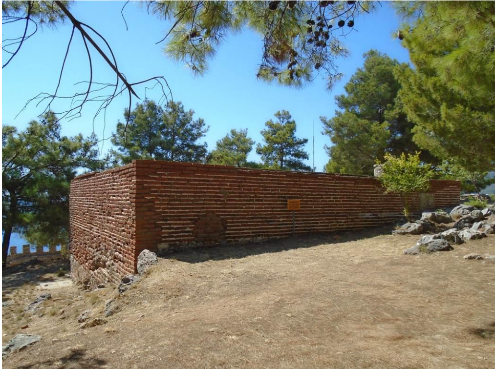
Görsel 3.7. İçkale 435 ada 1 Parsel Selçuklu Sarnıcı (Akman, N.)
