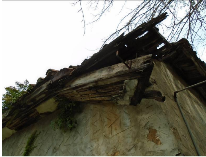
Görsel 3.45. Tophane Mahallesi 294 ada 14 parsel ahşap çatı oluğu (Akman, N.)
