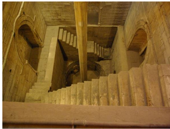
Görsel 3.2. Kahire’de Nil Nehri Kıyısındaki Ravza(Roda) Adası üzerinde nehir suyunun seviyesini ölçen Nilometre(Berthold Werner)
