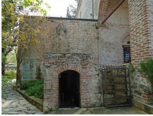
Görsel 3.10. Hisariçi Mahallesi 309 Ada 3 Parsel Süleymaniye Camii Sarnıcı ve Abdestlik (Akman, N)
