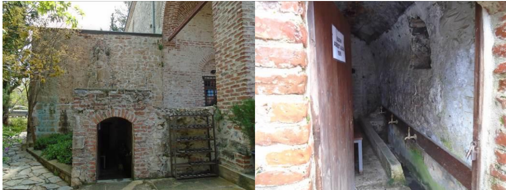
Görsel 3.60. Hisariçi Mahallesi 309 ada 3 parsel Süleymaniye Camii Sarnıcı ve Abdestlik (Akman, N.)
