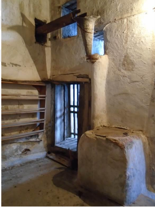
Görsel 3.48. Çatı yağmur suyu sisteminin sarniç bağlantısı (Akman, N.)
