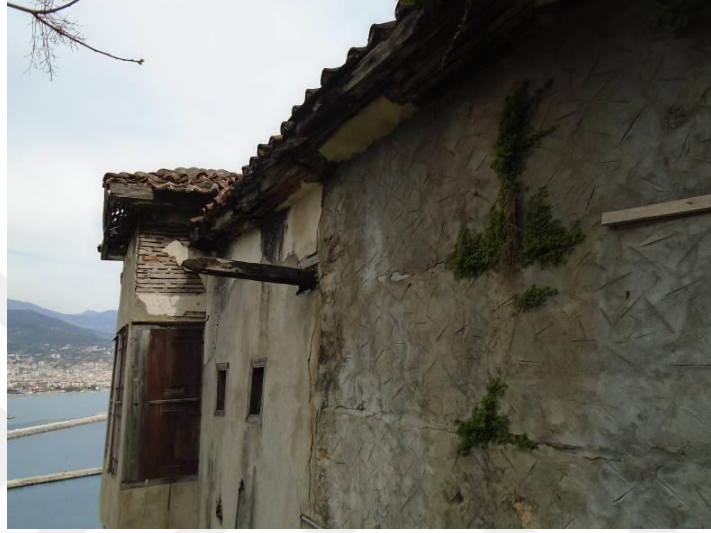
Görsel 3.46. Yağmur suyunu çatıdan sarnıç sistemine aktaran ahşap su oluğu
