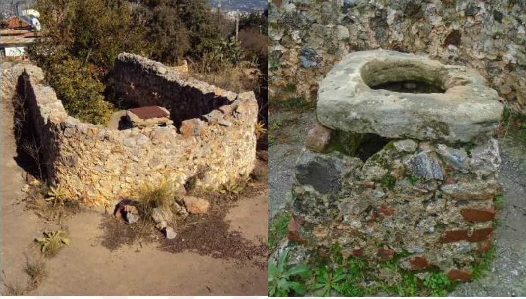
Görsel 3.53. Hisariçi Mahallesi 427 ada 7 parsel Keleşçe sarnıcı su alma bölümü ve sarnıç ağızı (Akman, N.)
