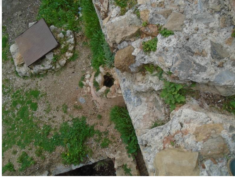
Görsel 3.65. 481 ada 3 parsel sur duvarında yağmur suyu hasadı sarniç girişi (Akman, N)
