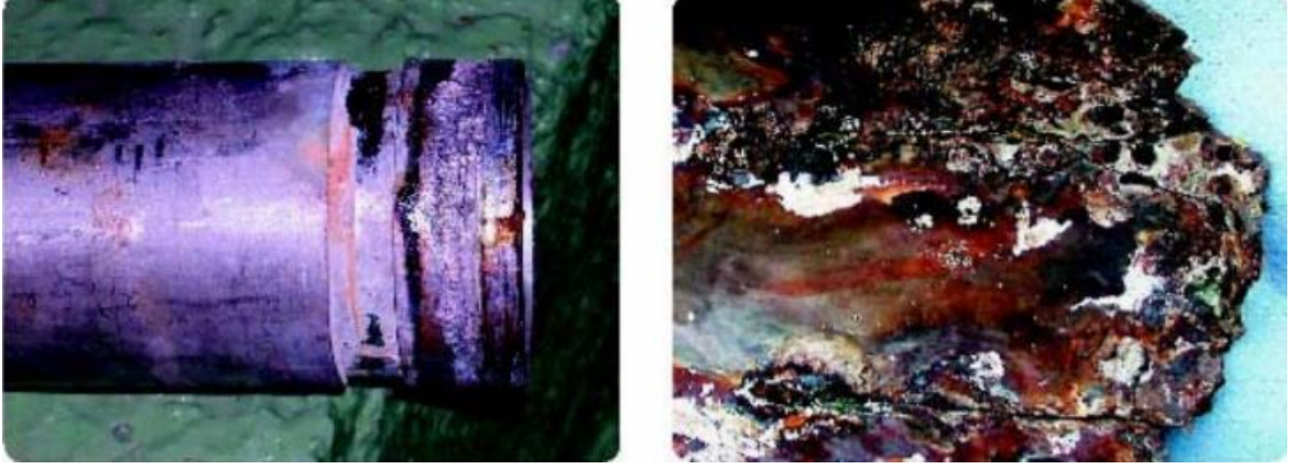
Şekil 2.26 Paslanmaz çelikte meydana gelen aralık korozyonu
