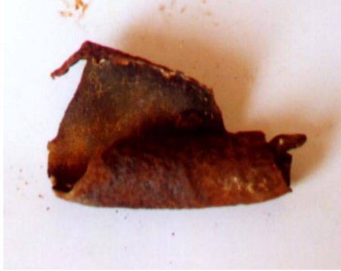
Şekil 2.28 Homojen dağılımlı korozyona uğramış boru parçası
