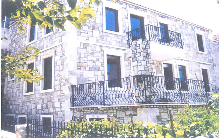
Resim 64: Yapı üretim sürecinde duvar örmede inşaat atıklarının kullanılması.
