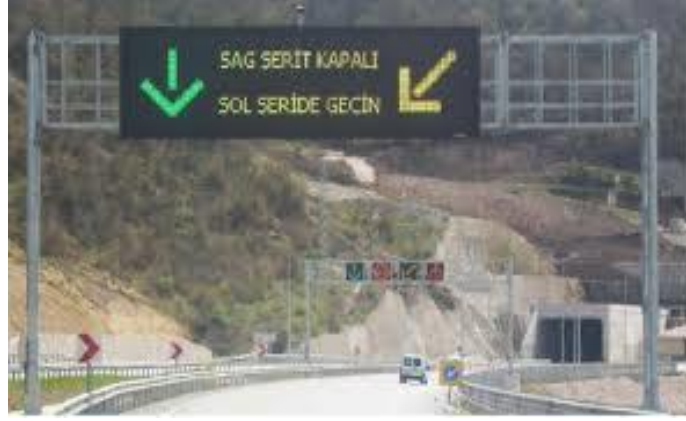
Şekil 27 Şerit Kontrol Sistemi (www.kgm.gov.tr, 26.08.2018)
