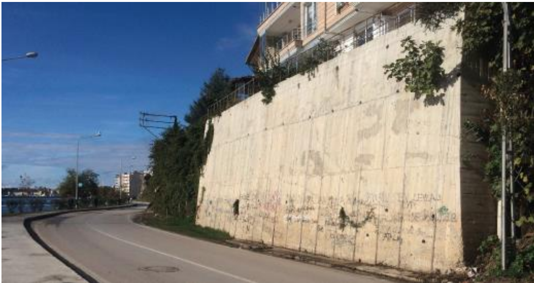
Resim 76 Karakum yolu istinat duvarı Mural uygulaması öncesi görseli
