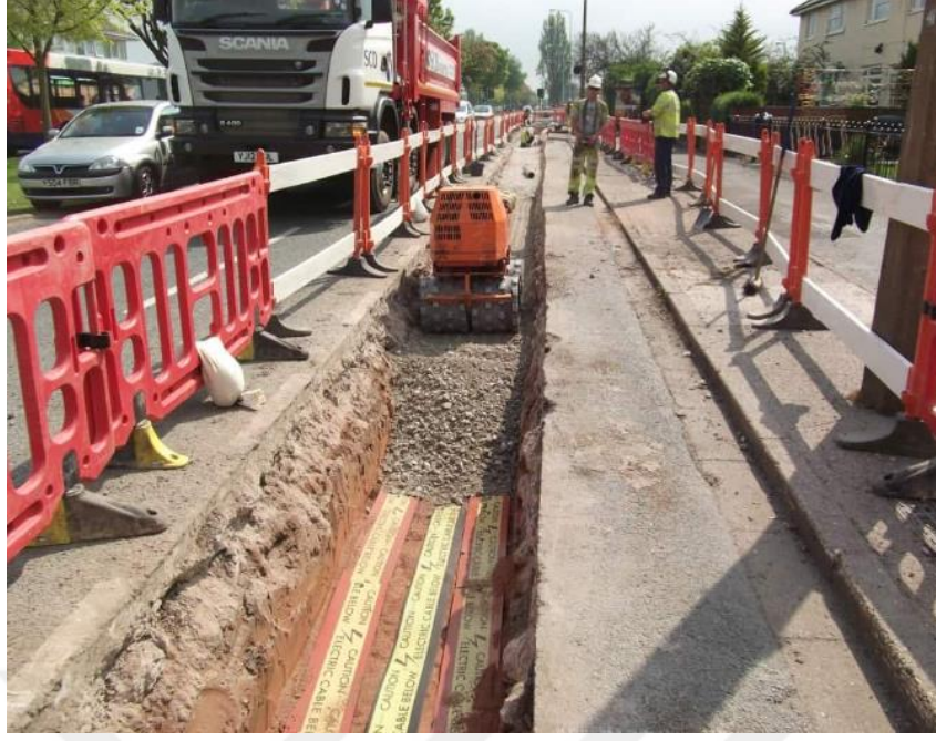
Şekil 2.12: Uyarı bandı serilmiş OG yer altı kablolama.
