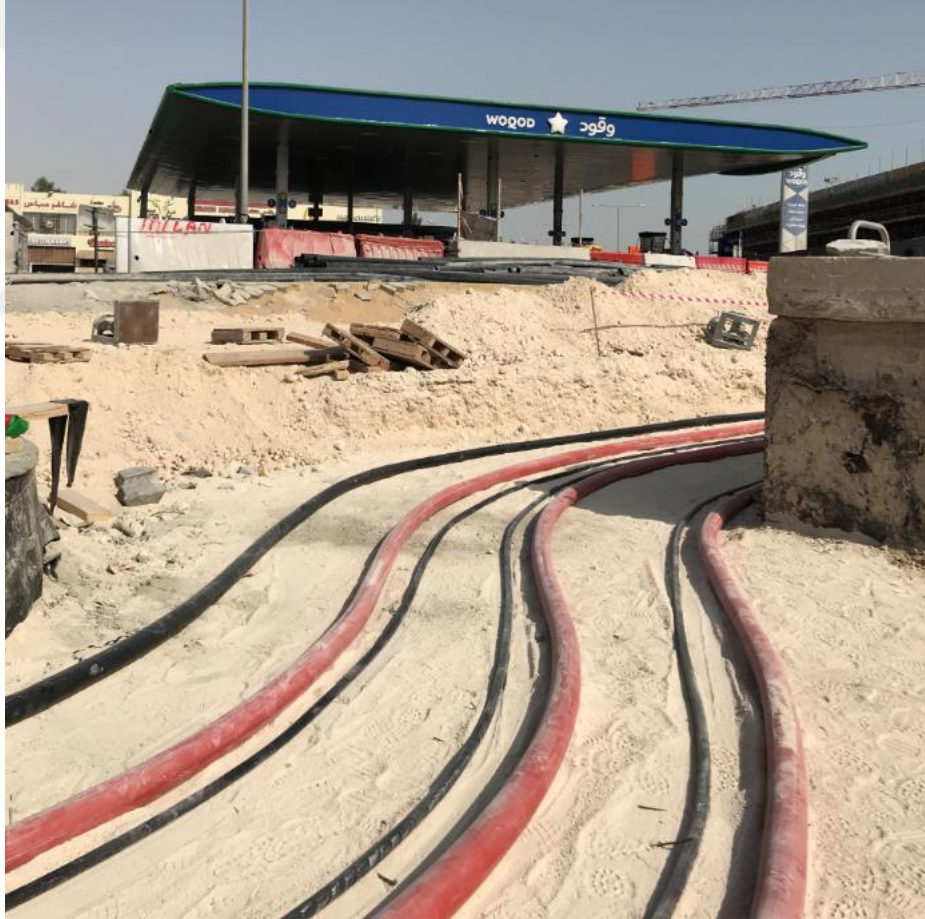
Őekil 2.9: Yer Altına Dőşenen AG, OG ve Pilot Kablolar.
