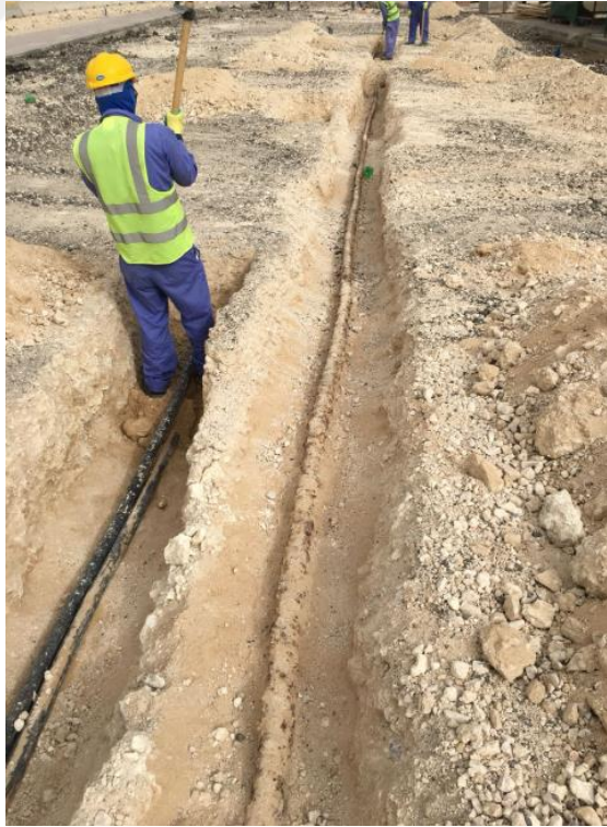
Şekil 2.15: Toprak altında zamanla deformasyona uğramış bir yer altı kablosu.
