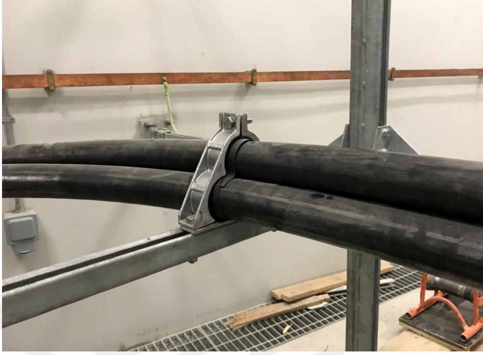
Şekil 6.9: Kablo dönüşleri ve kilit bağlantısı.
