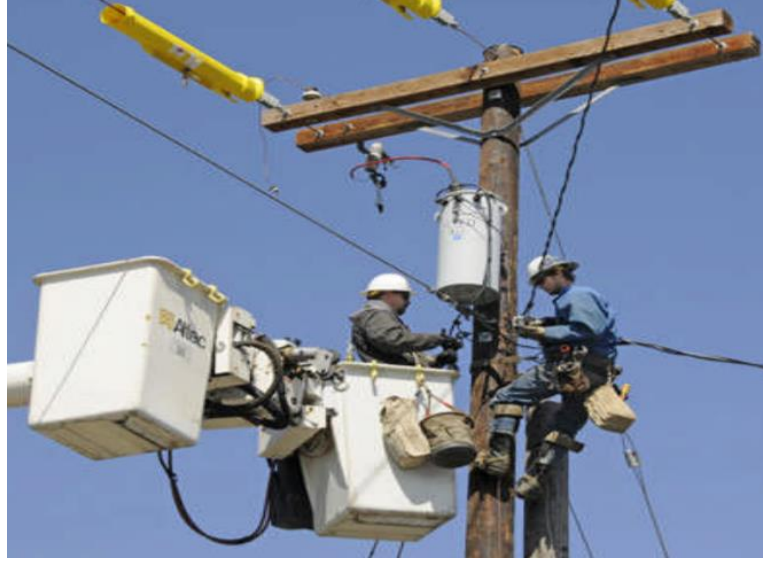
Şekil 2.4: Havai hatta bakım-onarım işlemlerini zorluğu.
