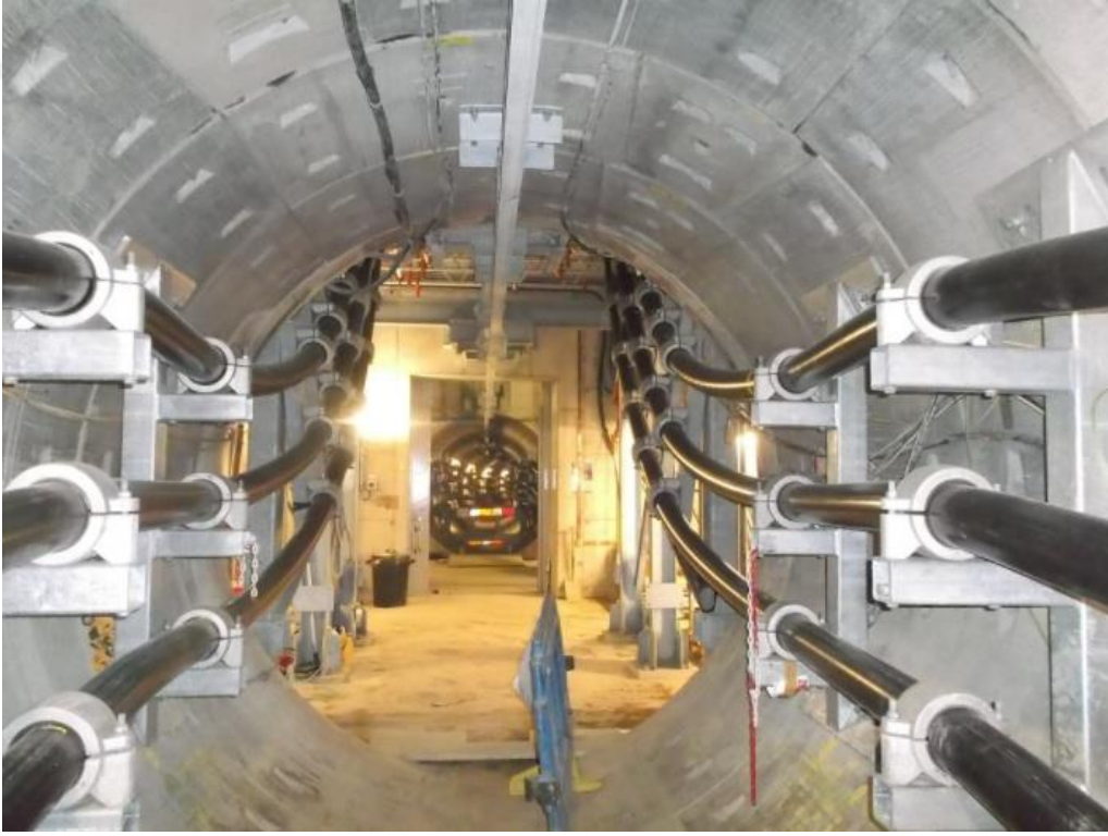
Şekil 6.16: Kablo tüneline çıkış şaftına bağlantı.
