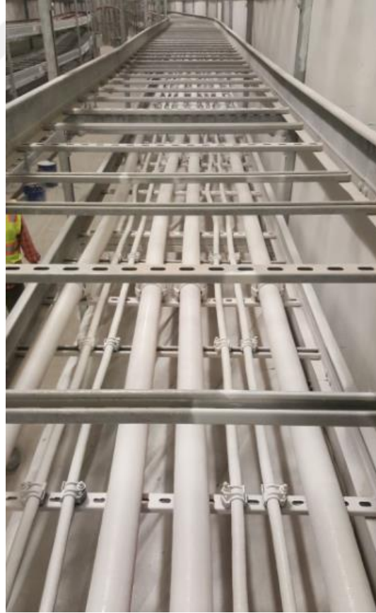
Şekil 6.13: Boyama işlemi tamamlanan YG kabloları.
