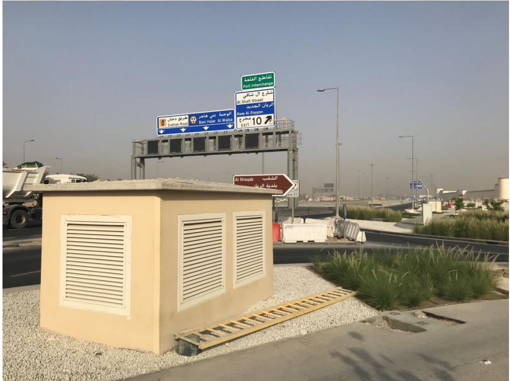
Şekil 6.22: Tünelere temiz hava girişini sağlamak amacıyla yapılmış başlıklar.
