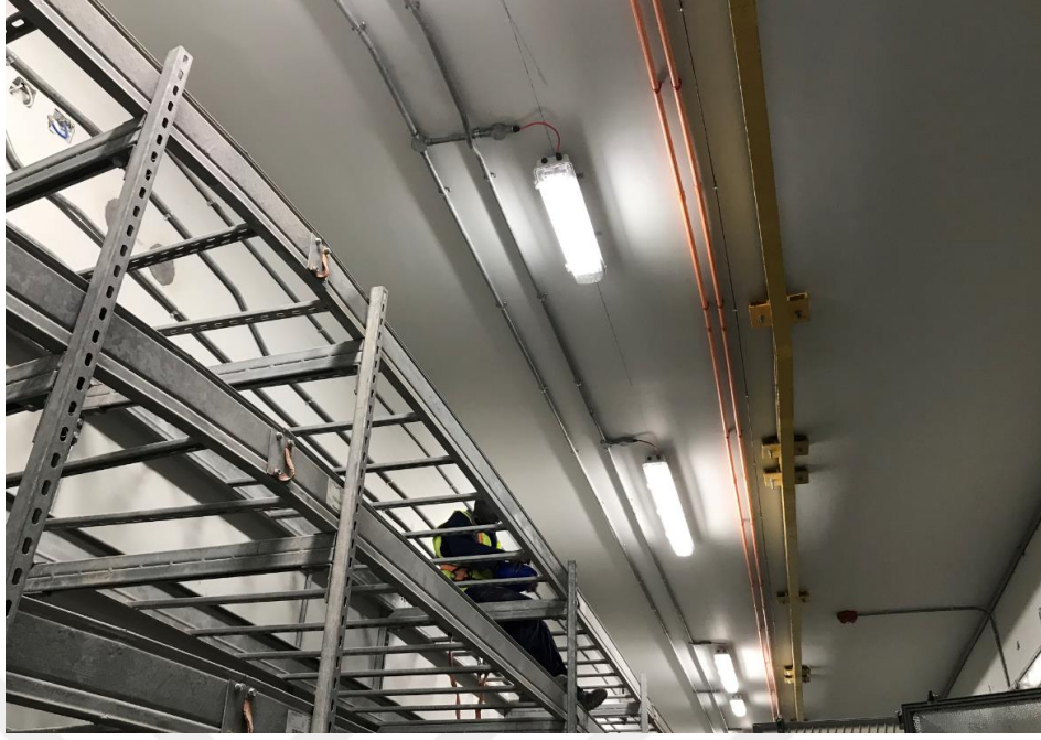
Şekil 6.7: Kablo abloların çekilmesini sağlayacak vincin geçeceği sarı renkteki ray.
