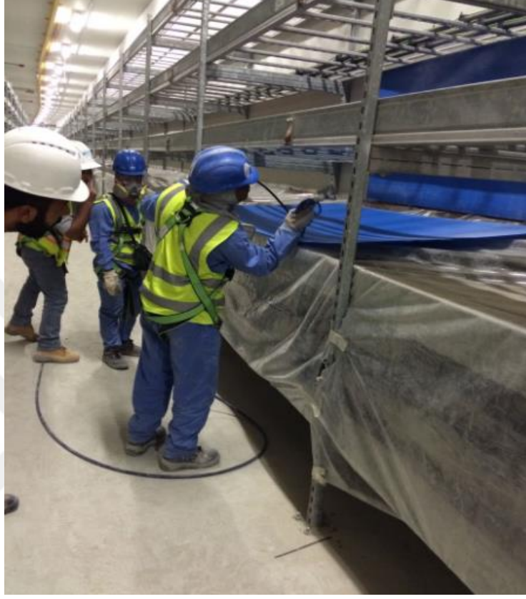
Şekil 6.11: Kablo tüneline boyama işlemi.
