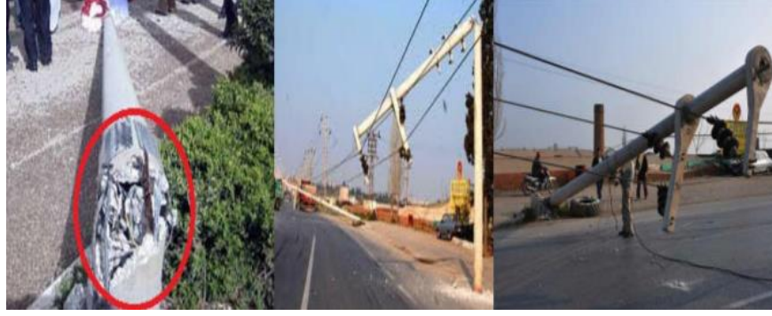
Şekil 2.7: Kırılarak yola doğru devrilen havai hat direkleri.
