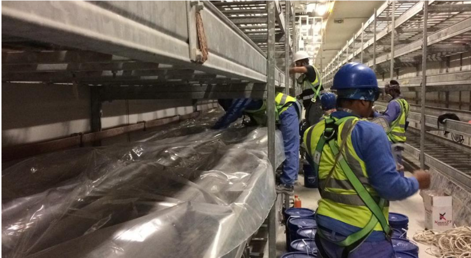
Şekil 6.10: Kablo kanallarını ve zemini boyadan korumak için yapılan hazırlıklar.
