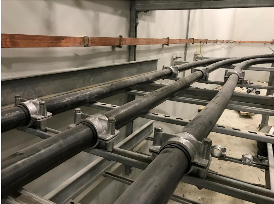
Şekil 6.8: Kabloların sabit durmasını sağlayan kilit bağlantısı.
