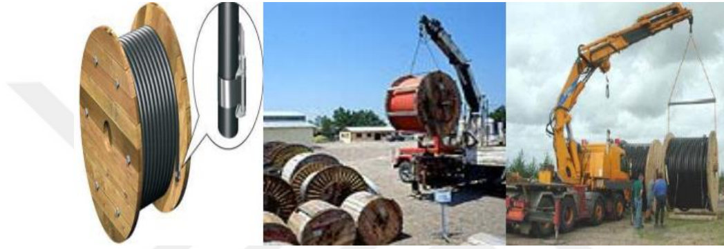
Şekil 2.10: Kablo makaralarının serim işlemine hazırlanması.
