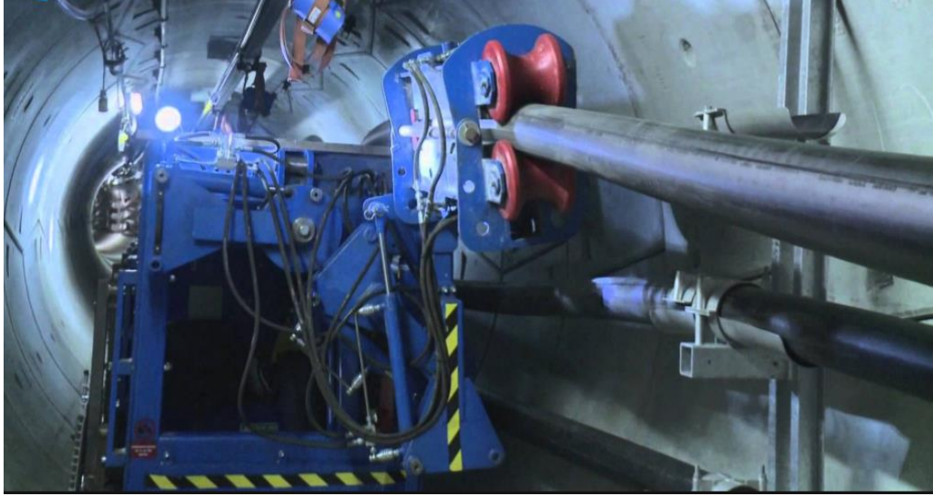
Şekil 7.3: Tünel içinde kullanılan kablo çekme makinası.
