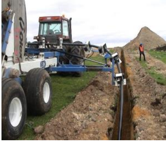
Şekil 2.11: Kablo kanalına iş makinesi yardımıyla bırakılan kablo.
