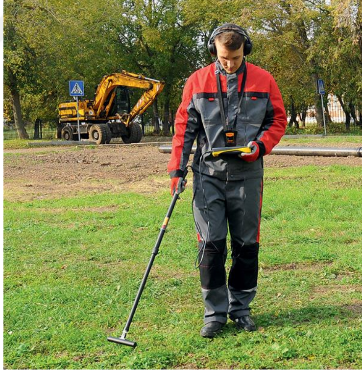
Őekil 2.14: Yer altı kablo arızası arama faaliyeti.
