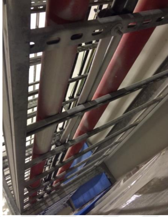
Şekil 6.12: Kablolarına uygulanan boyama işlemi (Uygulama esnasında).
