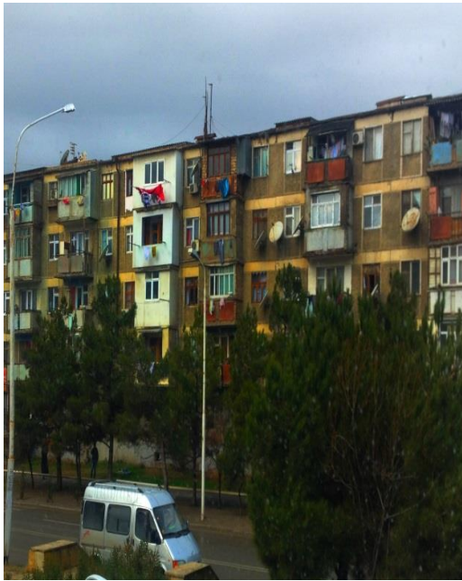
Şekil3.117: Sovyetler Dönemi Konut Binası (* – 03.11.14)
