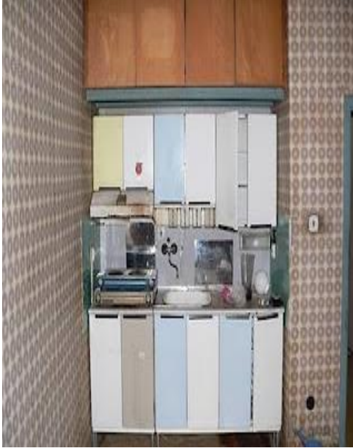
Şekil 3.111: Dairenin değişimden Önceki Mutfağı (Kaynak:www.aparo.ru – 02.10.14)
