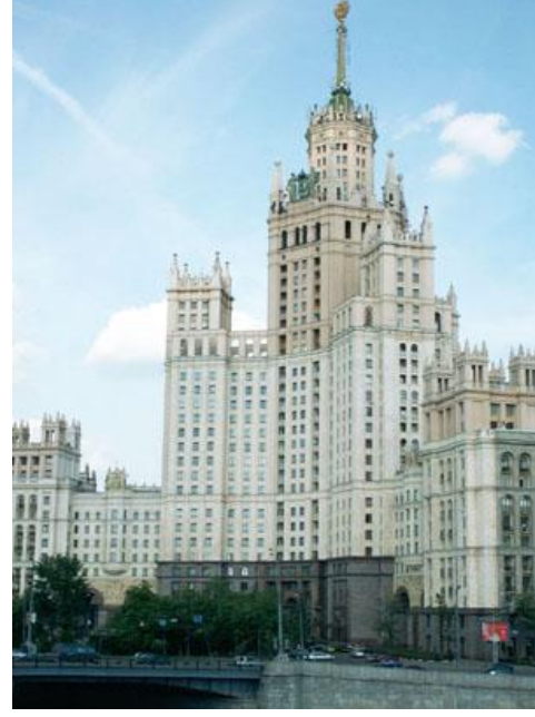
Şekil3.34: Kotelnicheskoy Naberejnyy Binası (Kaynak:www.livinternet.ru – 02.09.14)
