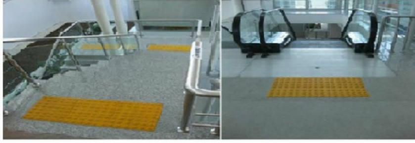
Resim 1.9: Merdivenler ve yürüyen merdivenlerdeki uyarıcı hissedilebilir yüzeyler
