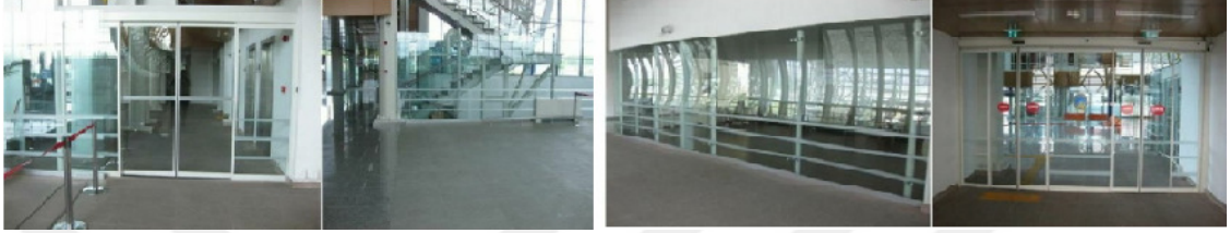
Resim 1.24: Beyaz renkli film şeritler ve yapıştırmalı etiketlerle belirgin hale camlı yüzeyler
