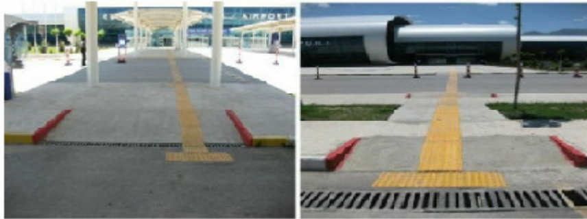
Resim 1.25: Kot farkını belli eden kırmızı renkli boyalı rampaların kenarları
