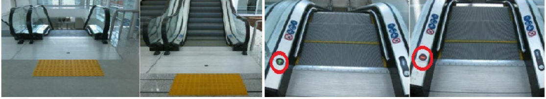
Resim 1.17: Hareket yönü bildiren uyarıcı kırmızı/yeşil ışıkla donatılmış yürüyen merdiven
