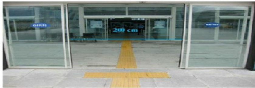
Resim 1.10: Akülü araçla rahat geçiş için kapılar açıldığında 200 cm. aralığı
