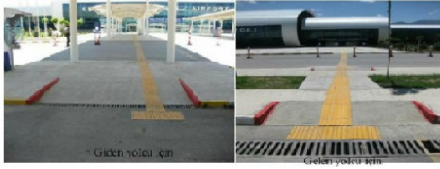
Resim 1.6: Giden/Gelen görme engelli yolcular için hissedilebilir yüzey çalışması
