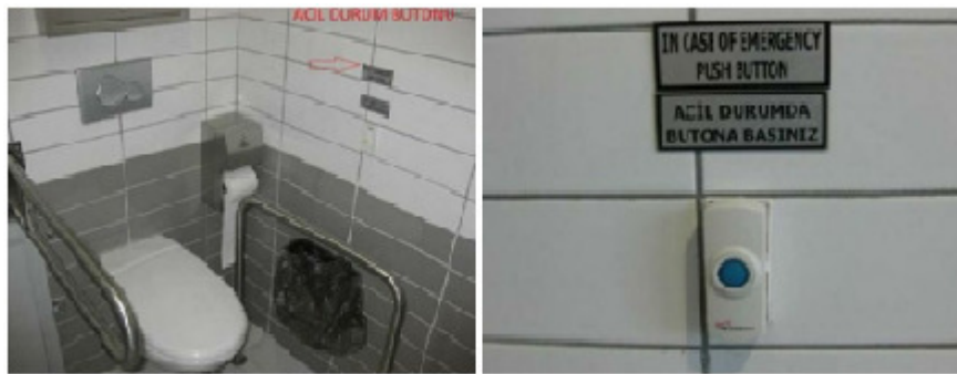
Resim 1.16: Engelli WC'si ve içindeki acil durum butonu
