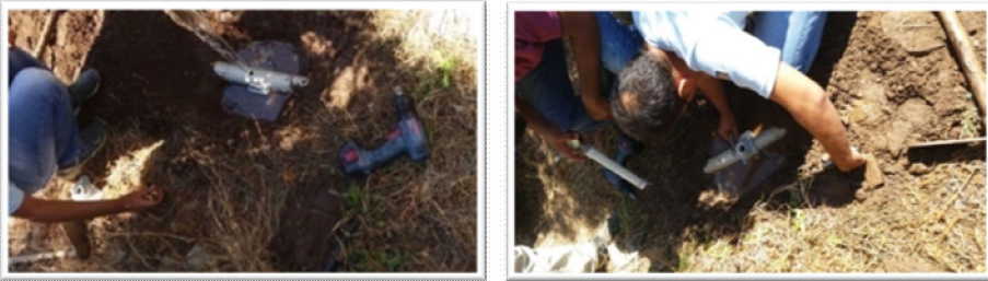
Şekil 3.3. Ana/manifold boruhattı basıncının ölçülmesi için manometre yerleştirilmesi
