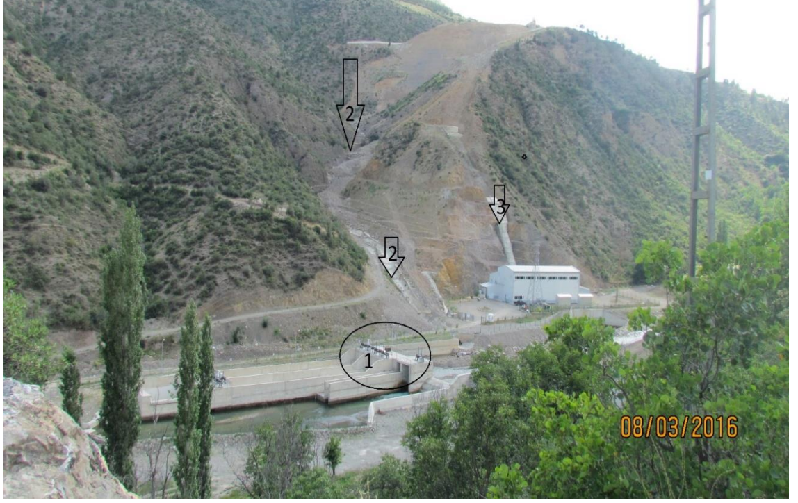
Fotoğraf 4.5. Bağbaşı HES Regülâtör Yapısı, 2 Tahliye Kanalı, 3 Cebri Boru
