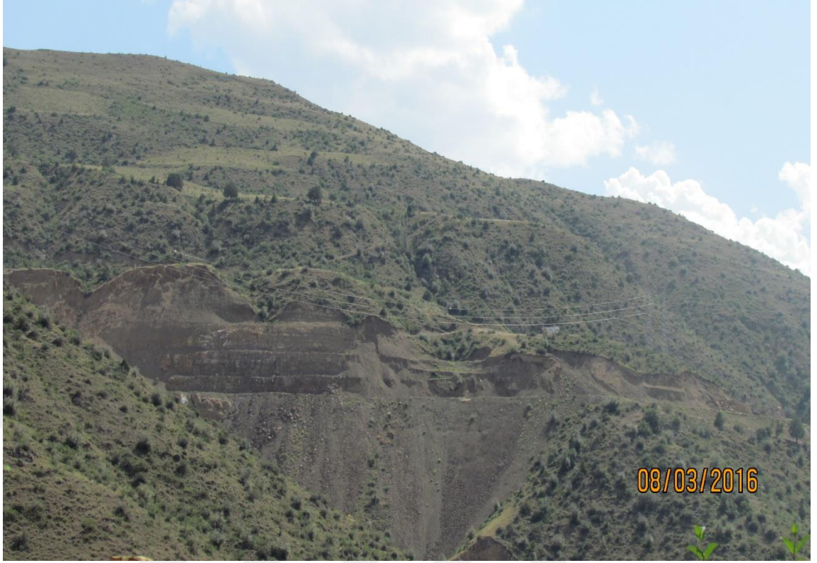
Fotoğraf 5.5. İletim Hatları İnşası Sürecinde Eğimli Olan Yamaçlarda Yamaç Dengelerinin Bozulması Sonucu Erozyon Şiddeti Artmıştır.
