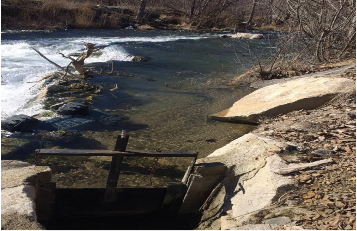
Fotoğraf 5.10. Kuyruk Suyu Zaman Zaman Sulama Amaçlı Oluşturulan Arkların Bozulması veya Tıkanması Gibi Problemleri Beraberinde Getirmektedir.
