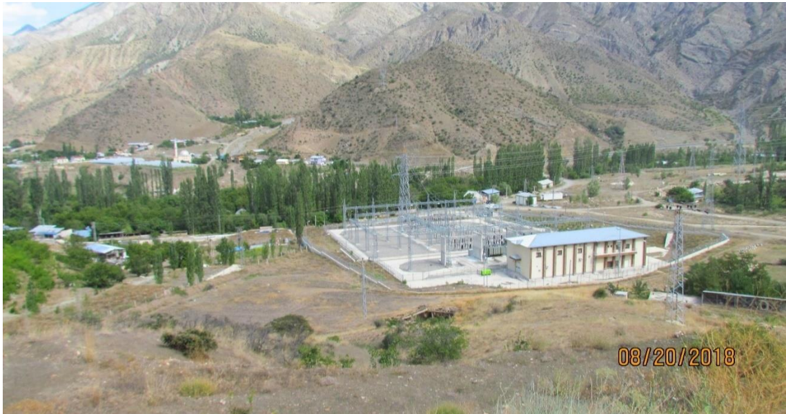
Fotoğraf 5.13. Elif Havza Trafo Merkezi ve Etki Sahası Çevresindeki Yerleşmeler.
