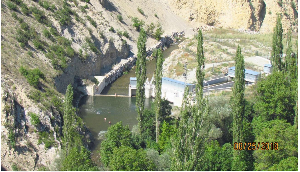
Fotoğraf 4.1. Büyükbahçe HES Regülâtör Yapısı
