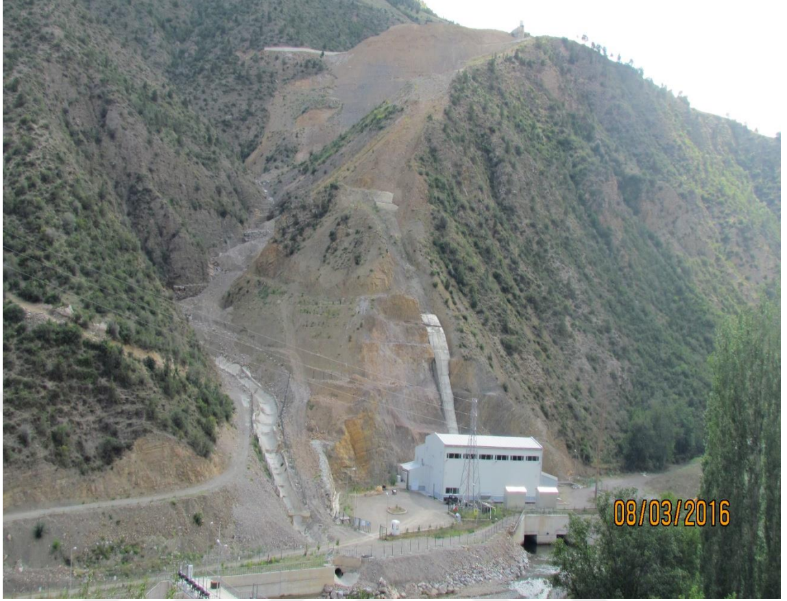
Fotoğraf 5.7. Büyükbahçe HES İnşasında Zarar Gören Bitki Formasyonlarından Bir Görünüm.
