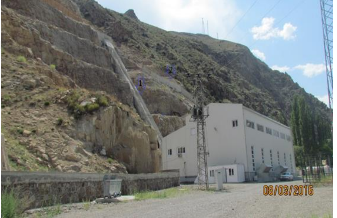
Fotoğraf 4.11. 1 Cebri boru, 2 Acil Tahliye Kanalı.
