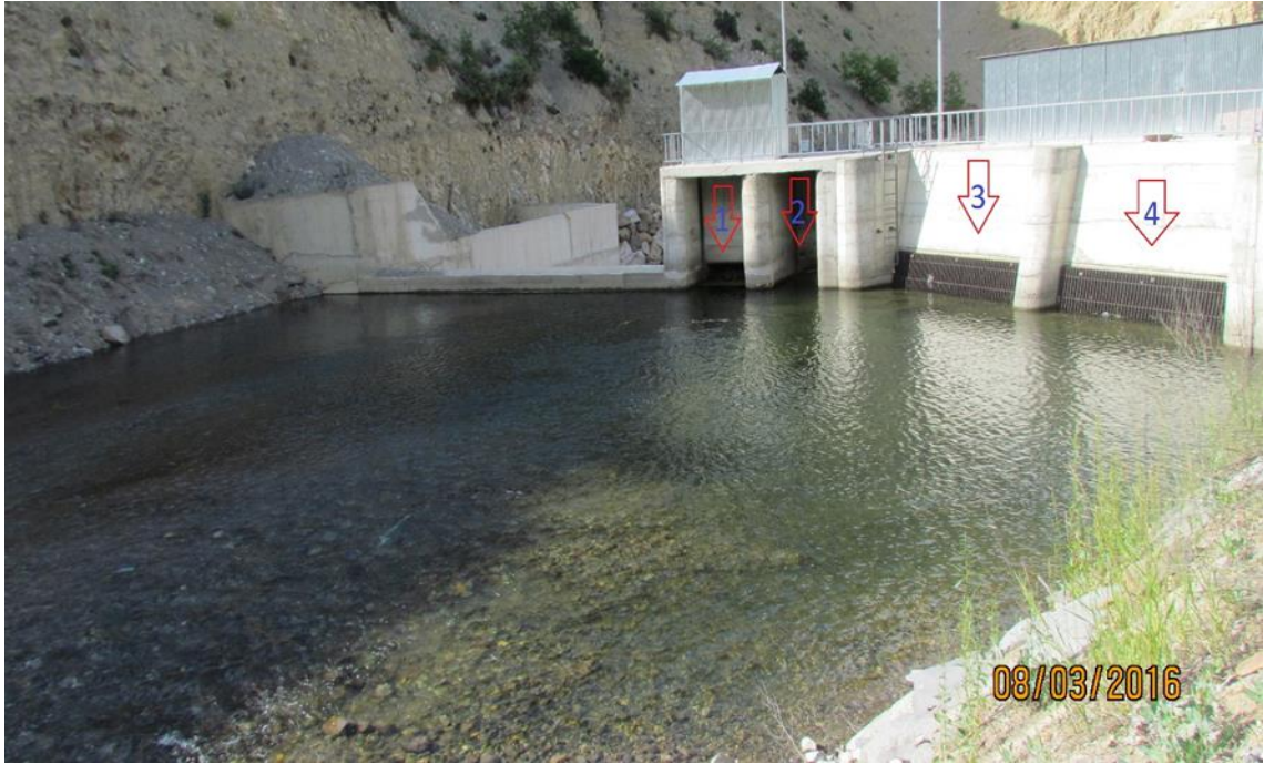
Fotoğraf 5.1. Regülatör Yapı Elemanları (1 Çakıl geçidi, 2 Balık geçidi, 3 ve 4 Filtre sistemi)
