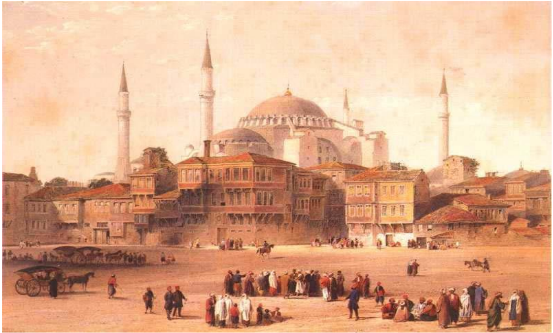
RESİM 2: Ayasofya'nın Fossati'nin restorasyonundan önceki görünümü (Fossati).
