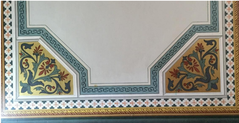
Fotoğraf 5.16.a Birinci Katta Yer Alan Orijinal Kalem İşi Çalışmasının Şimdiki Durumu
