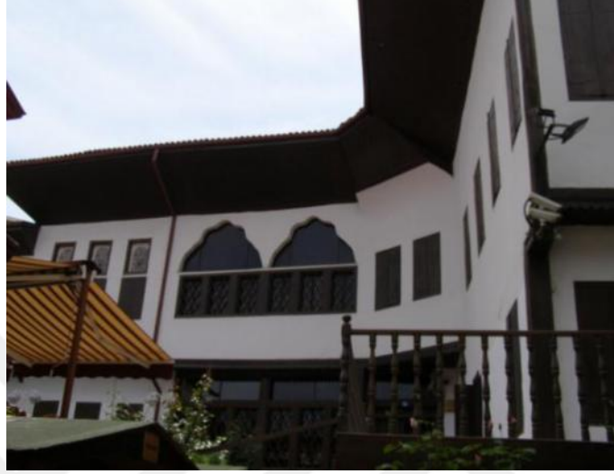
Resim 3.35. Latifoğlu Konağı'nın dıştan görünümü (E. Yetiş, 2016)
