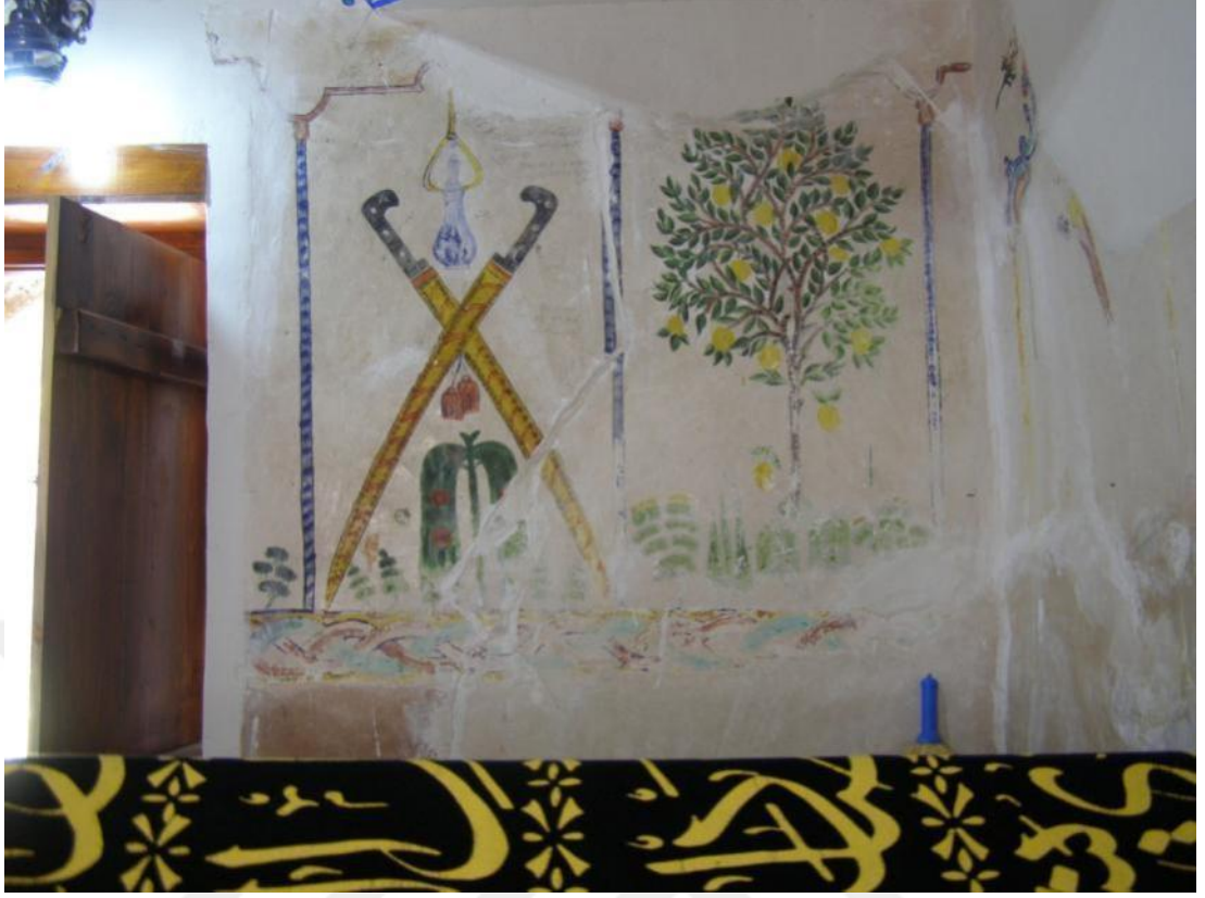
Resim 3.25. Şeyh Eylük Türbesi'nin kuzey cephesinin sağındaki duvar resimleri (E. Yetiş, 2016)
