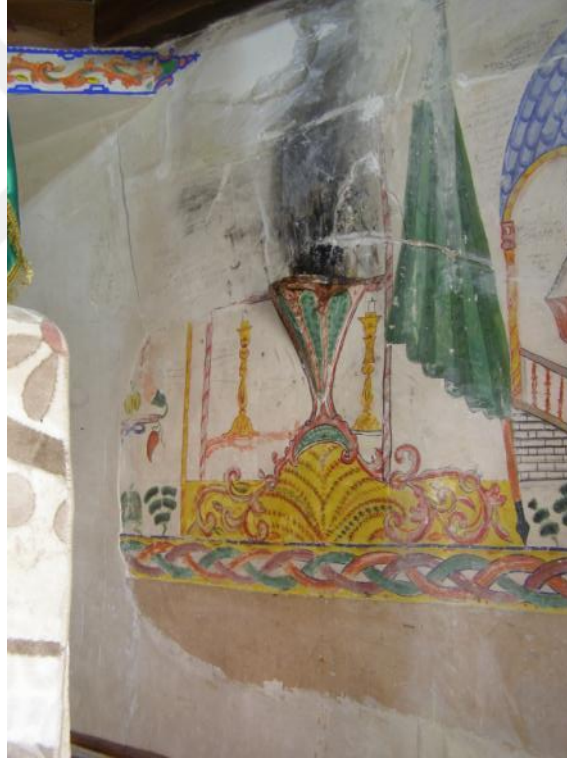
Resim 3.30. Şeyh Eylük Türbesi'nin batı cephesindeki duvar resimleri (E. Yetiş, 2016)
