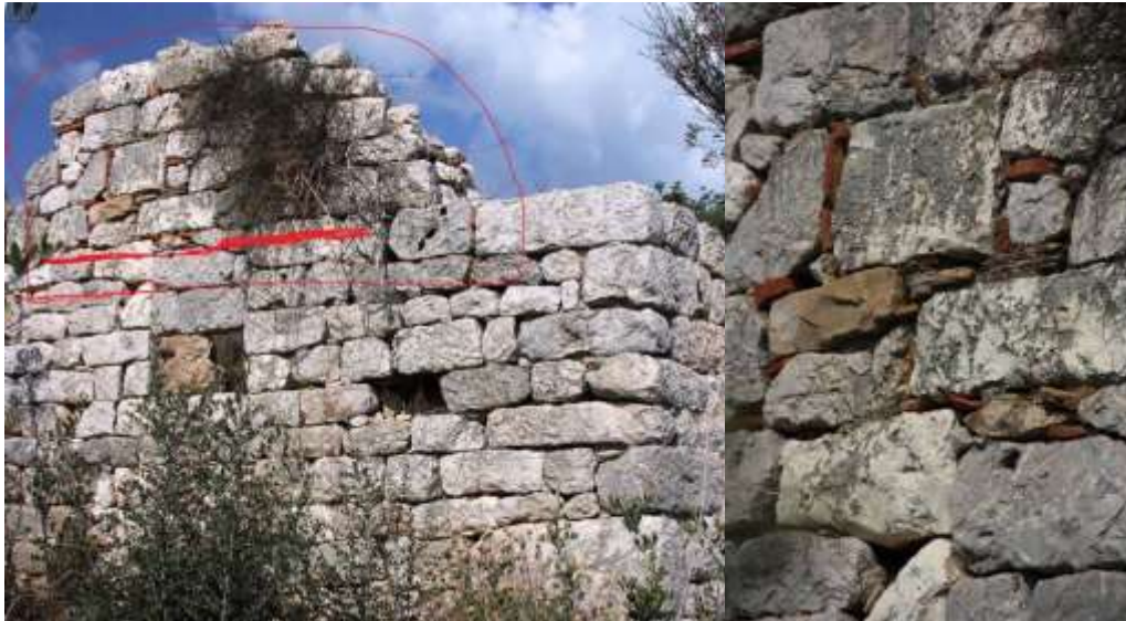
Resim 5.9. ST010 duvara sıkıştırılmış tuğla/kiremit parçaları
