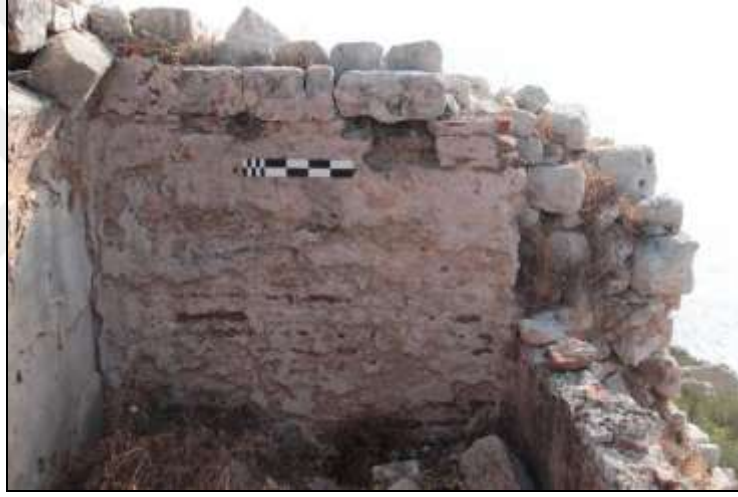
Resim 2.13. Tuğla duvar rgl sarnıç
