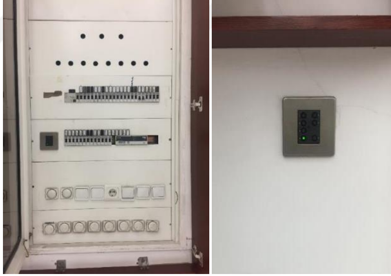
Resim 7.36. Müzenin bugüne kadarki tüm aydınlatma sistemine ait kontrol paneli (sol) ve DALI sistemine ait senaryo paneli (sağ) (2017)
