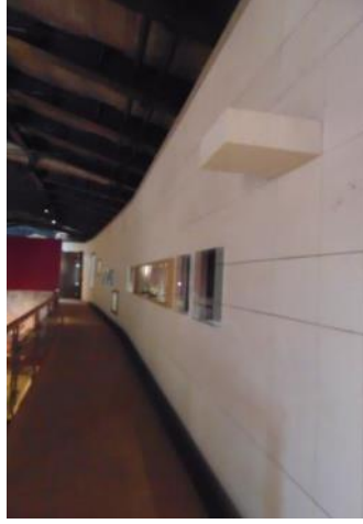
Resim 7.75. Zemin kat doğu duvarında yer alan sergileme ünitelerinin genel görünümü (2015)
