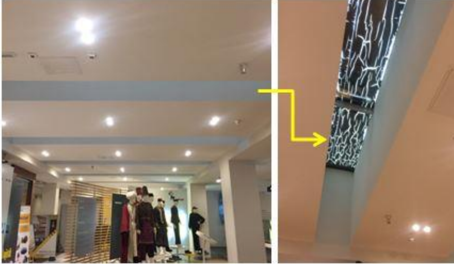
Resim 7.68. Zemin katta gün ışığının mekân içerisine alınmasının film ile engellenmesi (2016)
