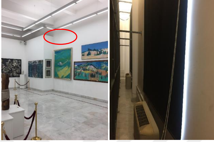
Resim 7.32. Sergi mekânlarındaki alçıpan duvarlar ve arka bölümü (2016)
