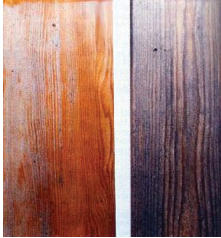
Resim 4.1. Ahşap üzerinde ışık hasarı; öncesi (solda), UV ışınlarına maruz kaldıktan sonra (sağda) (Zayat vd., 2007, s. 1273)
