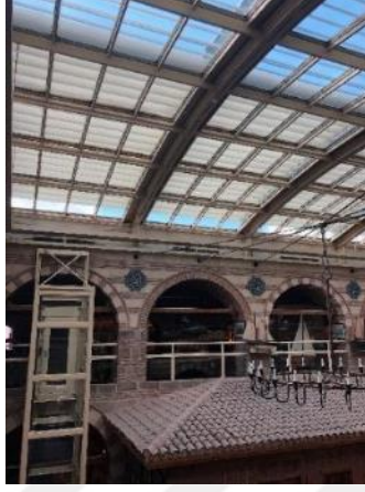
Resim 8.11. Çengelhan kısmının çatısında yer alan güneş kırıcı paneller (2018)
