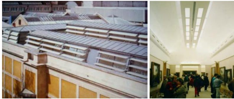
Resim 5.4. Tate Britain Müzesi otomatik ışık kontrol jaluzileri (sol) ve sistemin görünümü (sağ) (Wilson 2006, s. 158)
