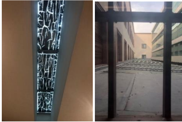
Resim 8.12. Cam yüzeyler üzerindeki film kaplamasının içeriden ve dışarıdan görünümü
